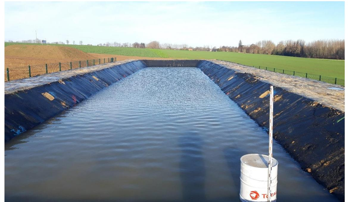
Utilisation des sols traités pour l'étanchéité et la protection mécanique
