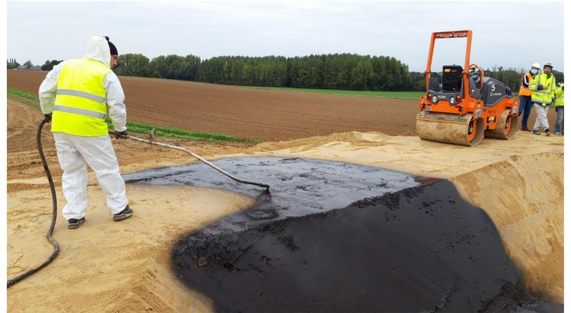
Utilisation des sols traités pour l'étanchéité et la protection mécanique
