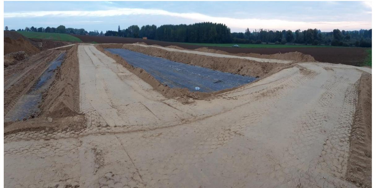
Utilisation des sols traités pour l'étanchéité et la protection mécanique
