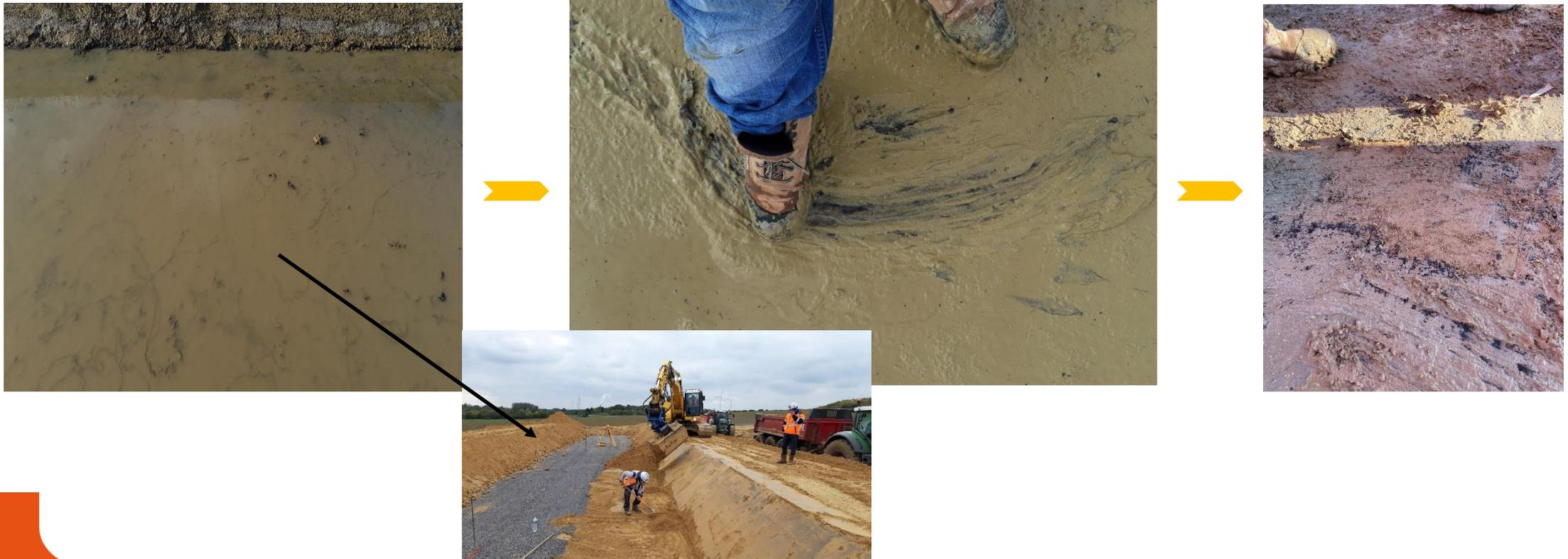
Utilisation des sols traités pour l'étanchéité et la protection mécanique
