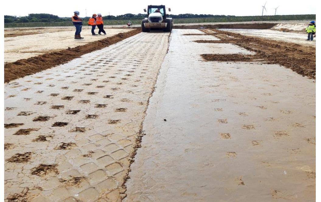
Utilisation des sols traités pour l'étanchéité et la protection mécanique
