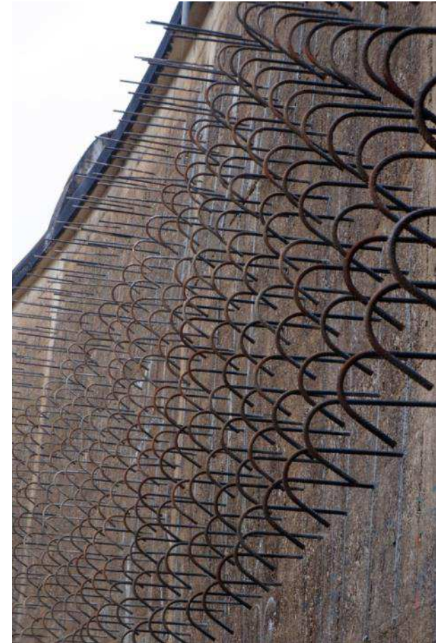
Photo : Ancrages dans la voûte
