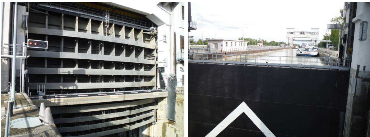
Graphique 17 : Mise en service du sas et éclusée du premier bateau
