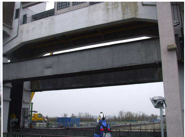
Graphique 1 : Tablier de l'ancienne porte vu depuis l'aval Graphique 2 : Contrepoids de l'ancienne porte
