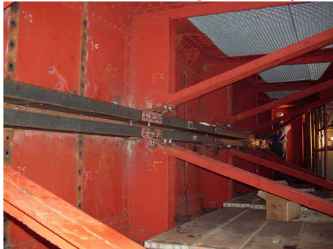
Figure 19 (ci-dessous): Vue des 2 nouveaux longerons centraux après remplacement
