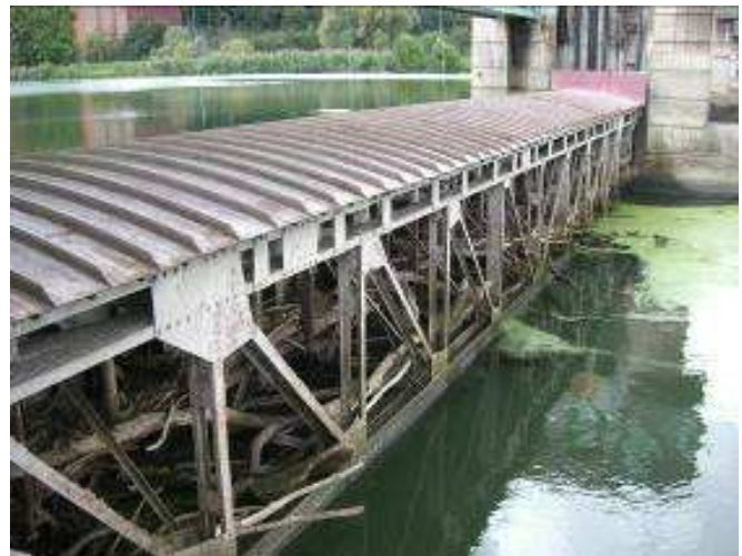
Photo 2 : Embâcles dans la vanne wagon
