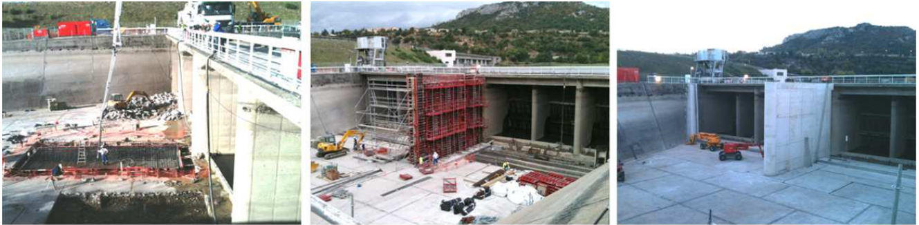
Travaux GC en cours
