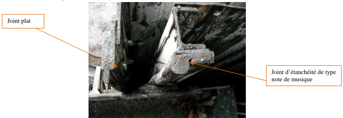
Figure 7 : Vue de système d'étanchéité inter-vanne de l'évacuateur n°1
