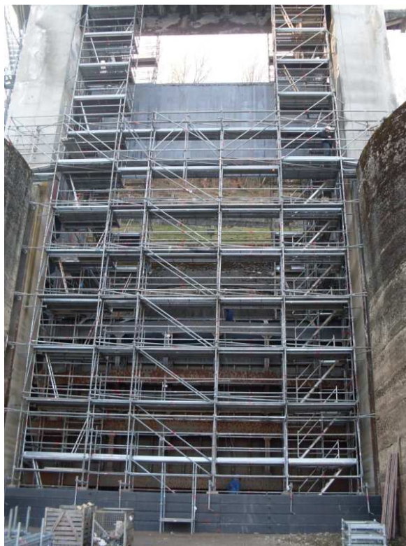
Figure 14 : Vue des échafaudages dans une passe et du batardeau amont
