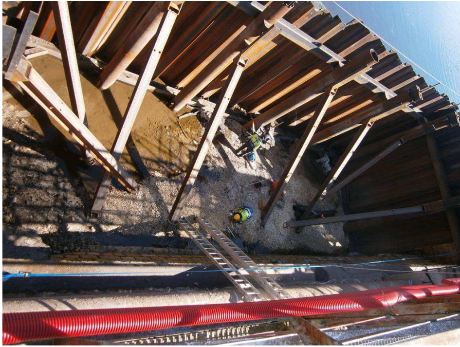
Figure 14 : photo d'une partie du batardeau amont
