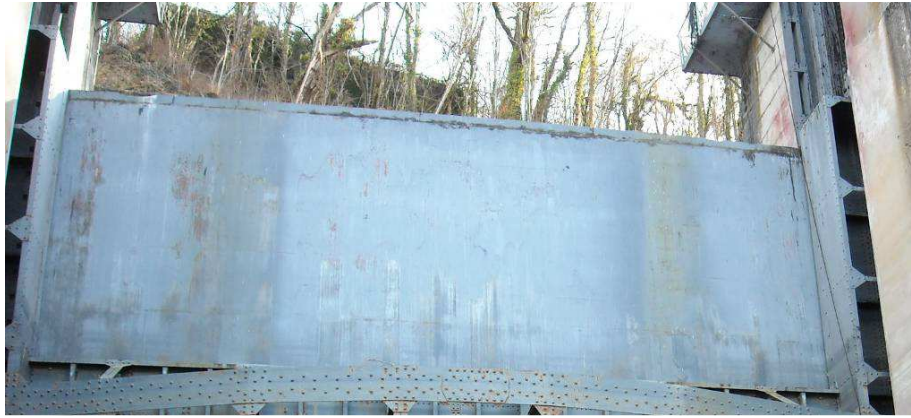
Figure 13 : Vue de la face amont d'une des vannes supérieures
