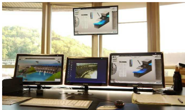
Graphique 9 : Salle de commande après travaux : modernisation de l'armoire électrique, du pupitre de commande et de la supervision.
