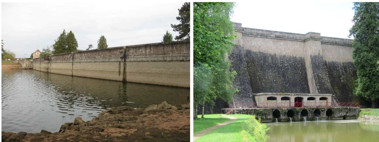
Graphique 1 : Vues du barrage
