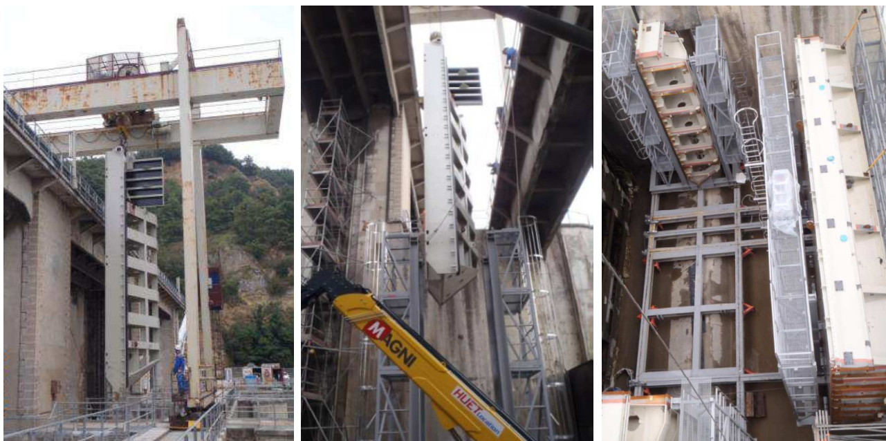
Figure 3 : Beaumont Monteux - manutention des morceaux de vanne
