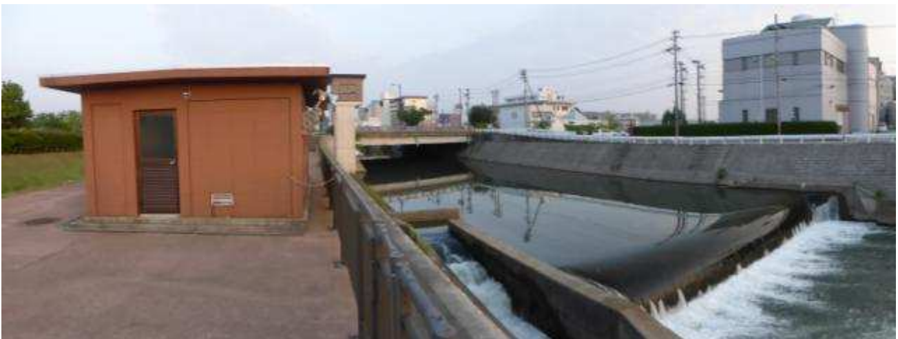
Figure 9 : exemple de local technique barrage gonflable de Toyama [crédit image © J.Aubonnet]
