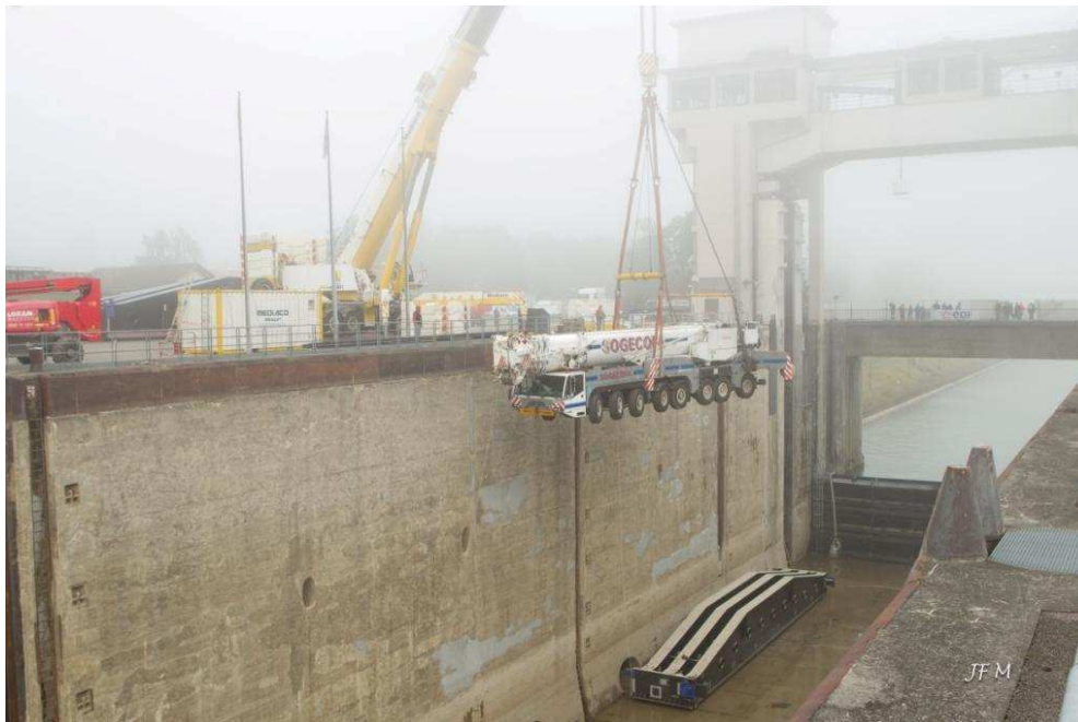
Graphique 11 : Descente de la grue 500T en fond de sas
