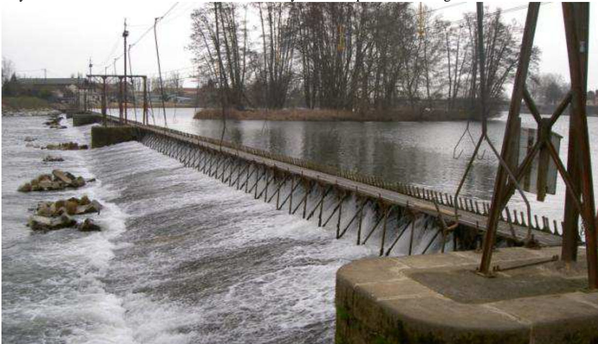
Figure 11 : barrage manuel d'Auxonne avant travaux [crédit image ©Voies Navigables de France]
