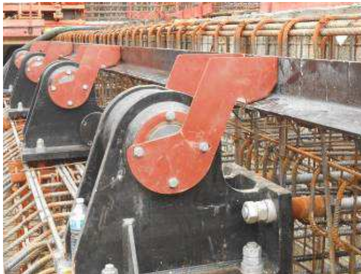
Figure 8 : Mise en place des paliers d'articulation
