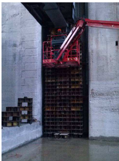
Graphique 14 : Vérinage du tablier de porte
