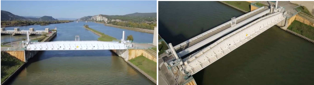
Figure 3 : Vue aérienne de la vanne renforcée après travaux
