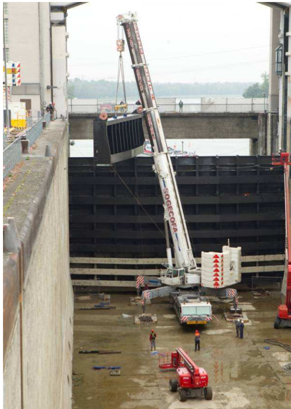
Graphique 12 : Montage du dernier élément de porte
