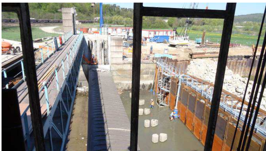
Photo 4 : Vue générale de la première passe en début de travaux
