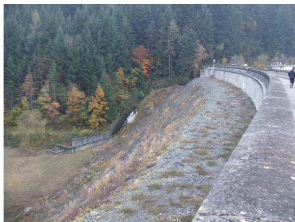
Graphique 2 : Barrage de Joux, vu de l'aval
