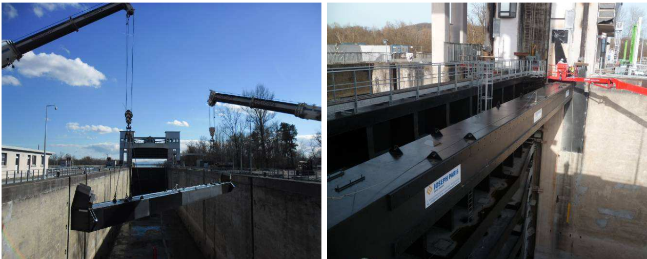
Graphique 13 : Montage de la poutre pare-chocs
