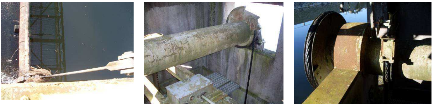
Figure 3 : Vue des différents éléments reliant le clapet au contrepoids (brimbale, poulie de renvoi, axe, câbles d'attache)
