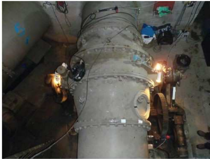
Figure 10 : Corps de la vanne de vidange de fond d'Izourt
