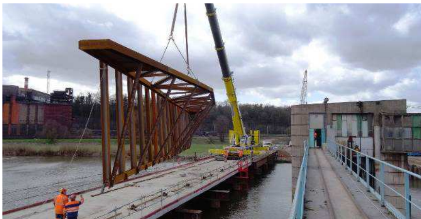
Photo 3 : Levage du batardeau de chantier amont sur l'estacade réalisée par BYTPRF
