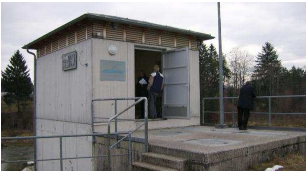
Figure 10 : exemple de local technique, barrage gonflable de Lechbruck [crédit image © J.Aubonnet]
