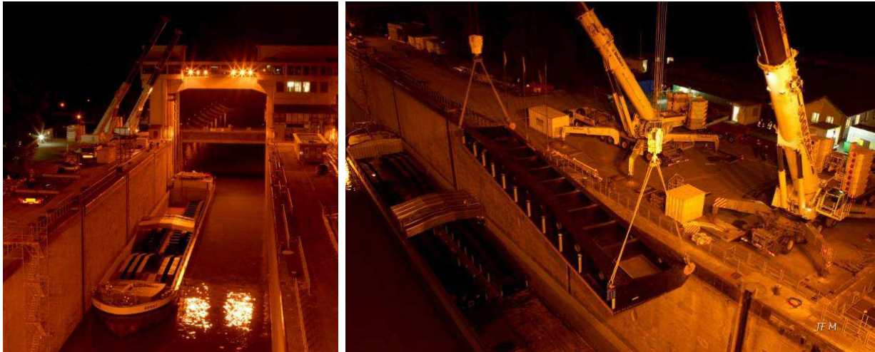
Graphique 10 : Déchargement des éléments de porte avec les grues 500T et 700T
