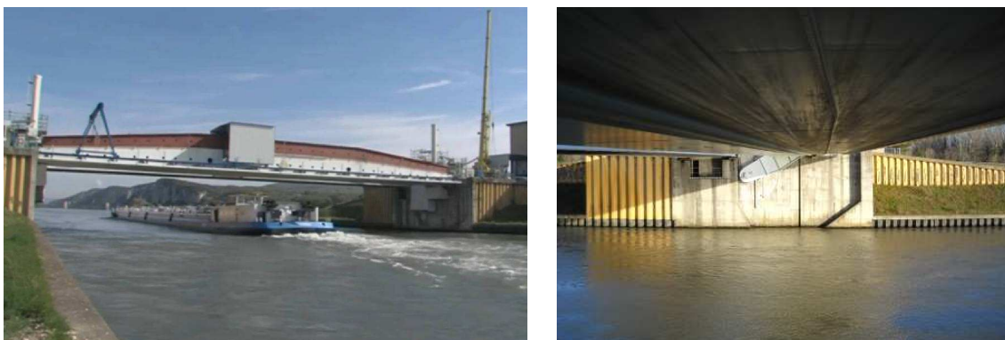
Figure 16 : Passage d'une péniche en phase de travaux
