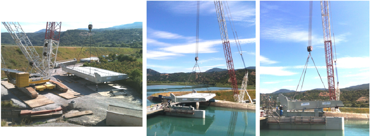
Photo 10: Grutage du clapet RG
