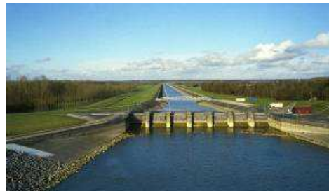
Schéma 4 : Exemple du déversoir d'extrémité du canal d'amenée Marne.
