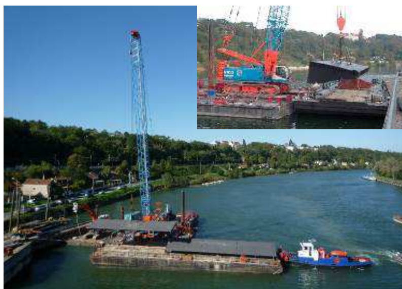
Figure 10 : Acheminement d'un tronçon de clapet par grue sur barge
