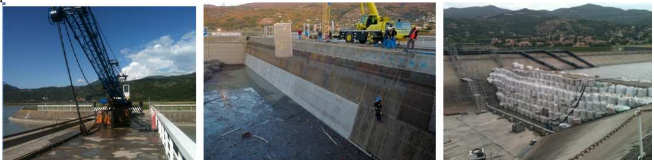
Photo 8: Grappinage et désenvasage – Batardage amont du plan de grille - Batardeau Big bag aval et siphons
