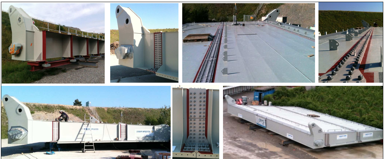
Photo 9: Montage des tronçons des clapets – liaisons éclissées
