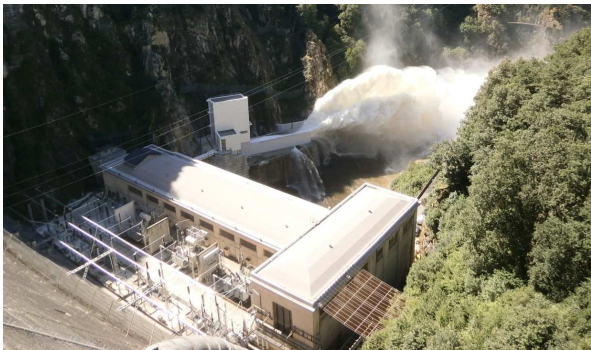
Graphique 9 : Essais de qualification à 643,00 m NGF, vue du couronnement.
