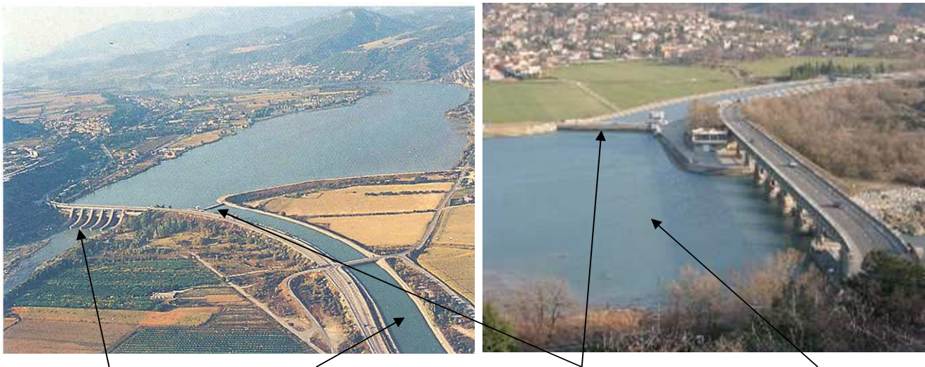
Barrage mobile Escale - Canal d'Oraison - Prise d'eau du canal d'Oraison - Retenue de l'Escale
