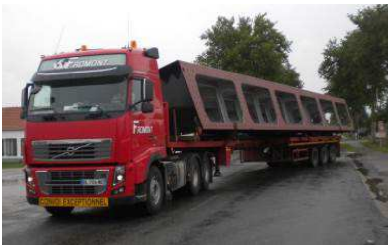
Figure 9 : Transport d'un tronçon de clapet du Coudray-Montceaux
