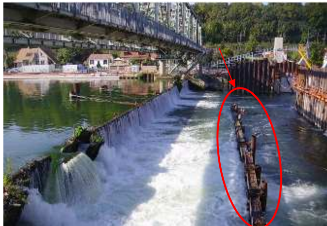
Figure 13 : Rideau de protection à l'aval des hausses instables
