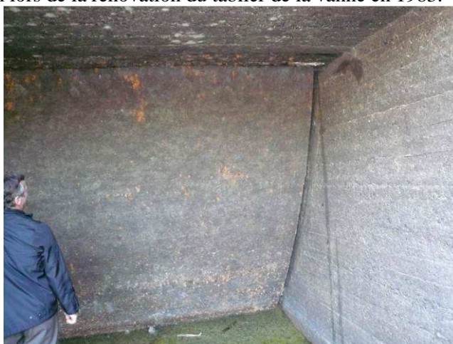
Graphique 7 : Vue amont de la tole de bordée de la vanne
