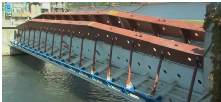
Figure 15 : En phase travaux, sous 48h, la vanne peut être rendue fonctionnelle et restituée temporairement à l'exploitant.
