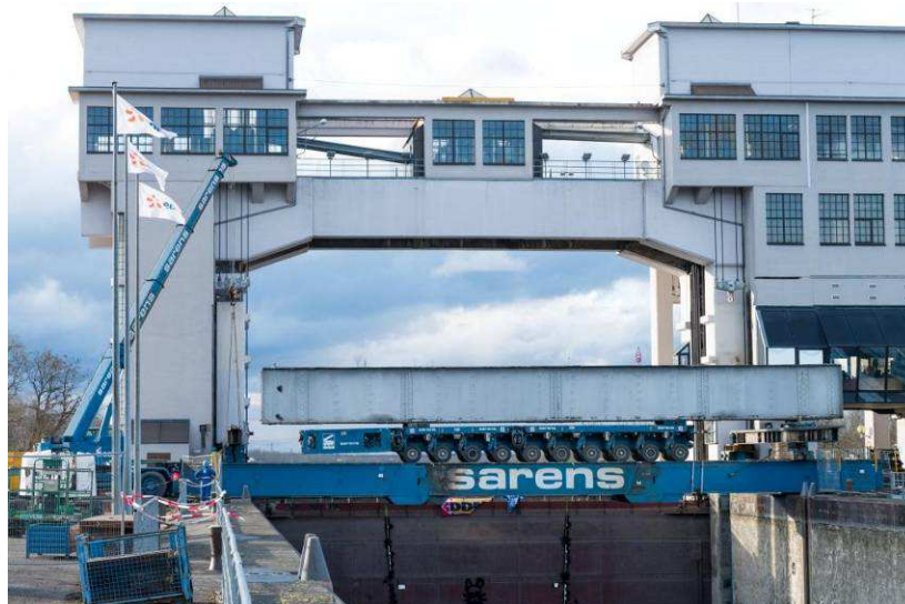
Graphique 6 : Enlèvement des contrepoids après vérinage et ripage
