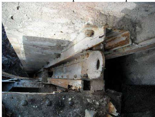
Figure 5 : Vue de l'étanchéité latérale
