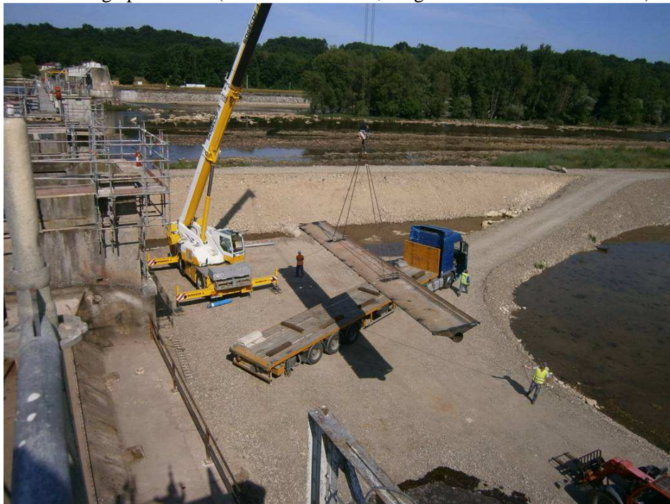
Figure 15 : Vue de la digue et de la piste d'accès
