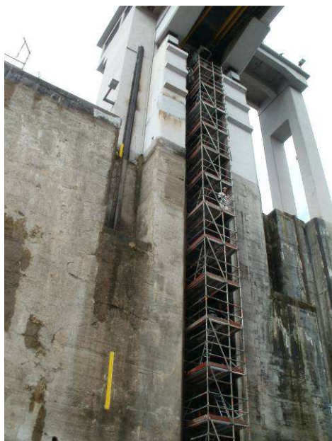
Graphique 8 : Remplacement des rails de guidages amont et aval
