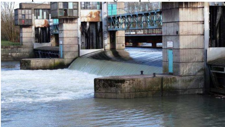
Photo 1 : Vue aval de la passe centrale avec vanne wagon
