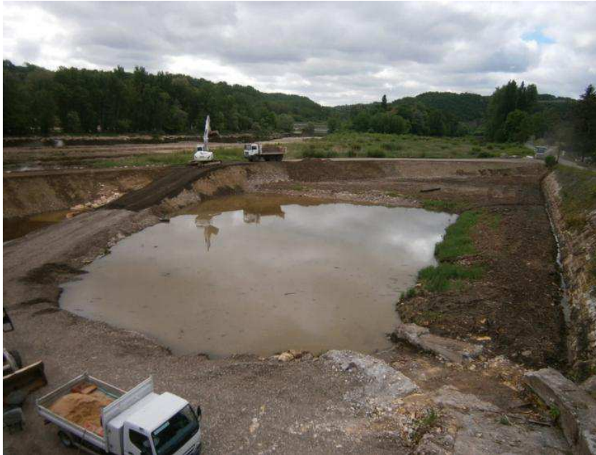
Figure 16 : Autre vue de la digue et de la piste d'accès
