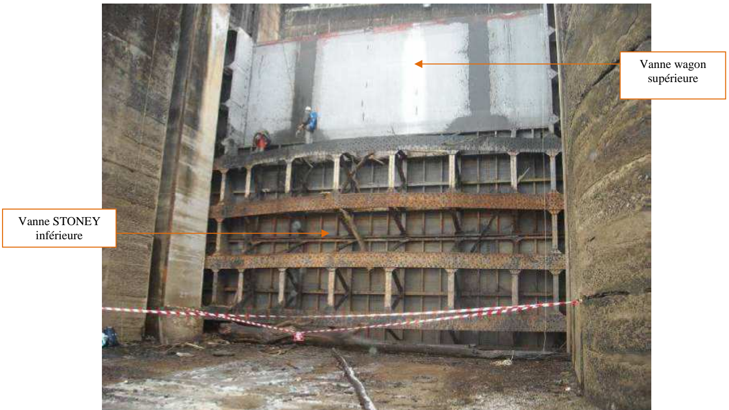
Figure 2 : Vue des 2 vannes depuis l'amont
