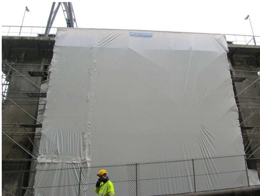
Figure 17 : Vue d'une partie du confinement
