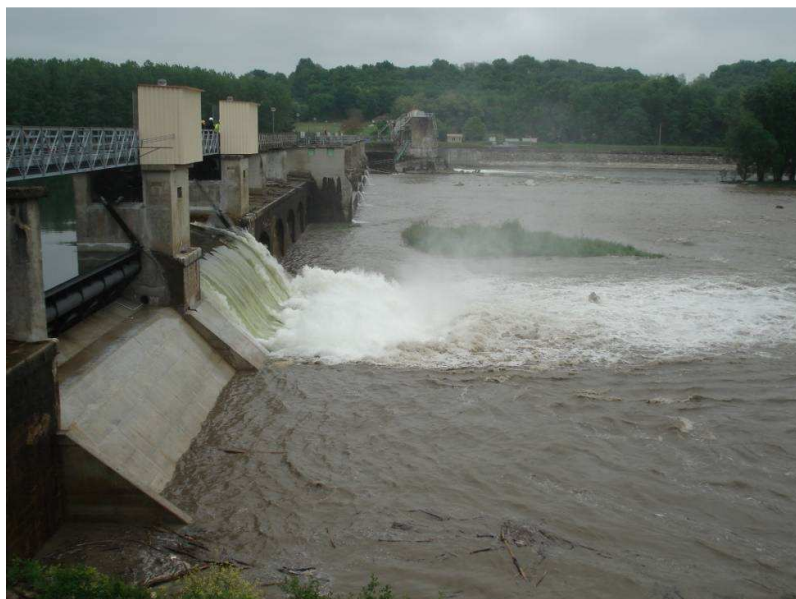
Figure 17 : Photos des clapets lors des essais de mise en service
