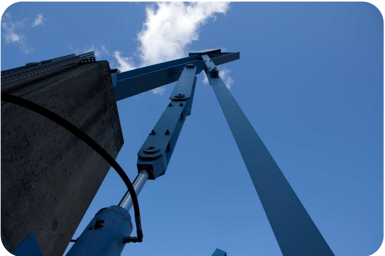
Systeme d'ouverture des vannes de crues du barrage de Sampolo © EDF – Bruno CONTY
