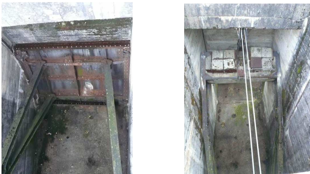
Graphique 6 : Tablier aval de la vanne et contrepoids
