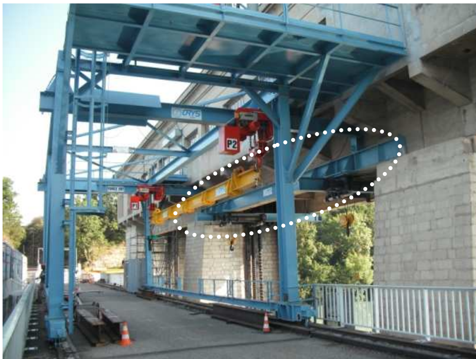
Graphique 5 : Portique de manutention et ensemble 2 monorails (entouré)
