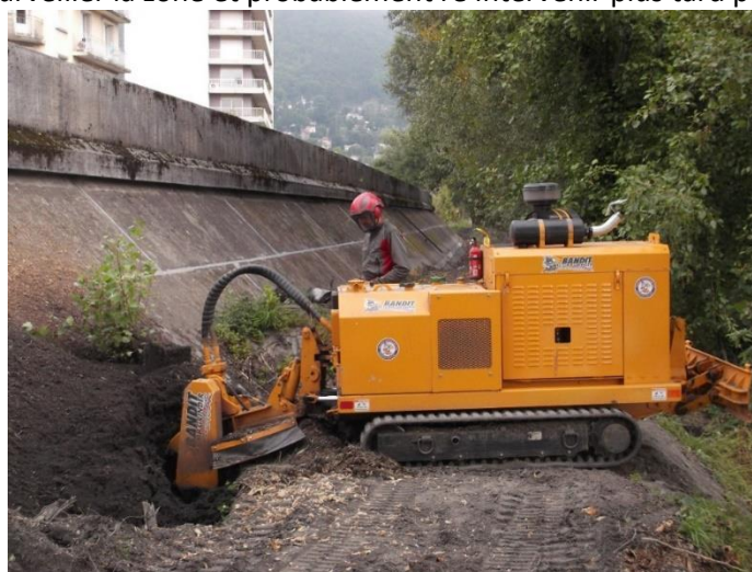
Figure 9.3 : Photographie d'un abattage définitif avec rognage du tronc au droit du terrain naturel (Crédit photo : ADIDR – 2014 – Grenoble Isère RG (38))
