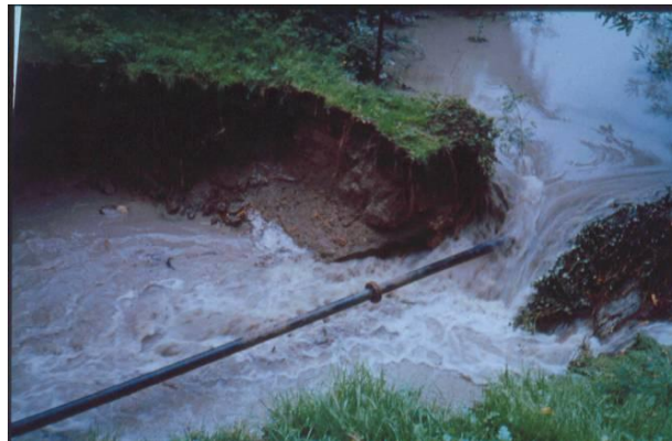
Figure 8.6 : Brèche dans une digue, au droit d'une conduite traversante sur le Rhône (Crédit photo : SNRS)
