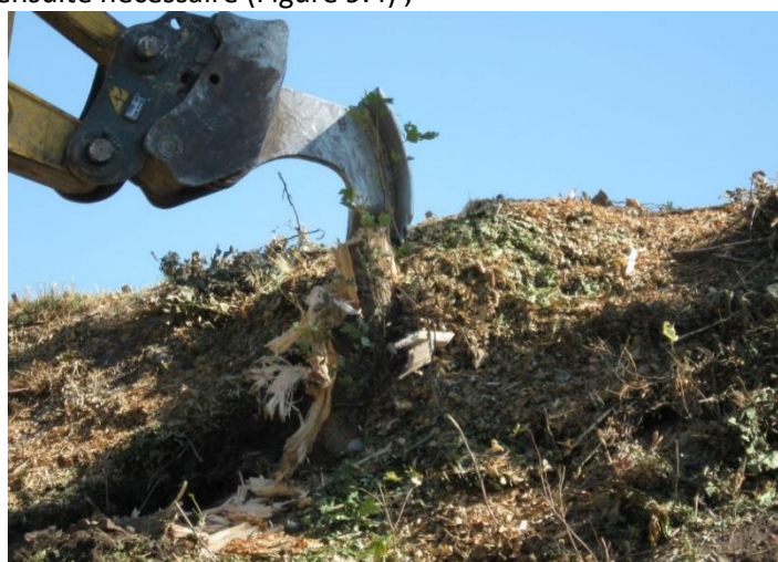
Figure 9.4 : Photographie d'un abattage définitif avec extraction partielle de la souche (Crédit photo : ADIDR – 2009 – Drac RG – Fontaine (38))
