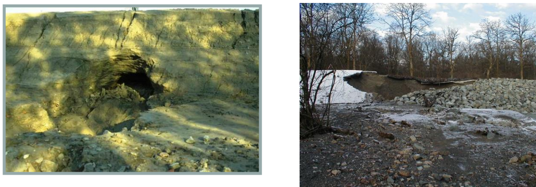
Figure 10.1 : Brèche partielle par érosion interne (Photo : Cyril Folton / Patrice Mériaux) (à gauche) et Brèche partielle par surverse (Photo : Patrice Mériaux / Paul Royet) (à droite)
