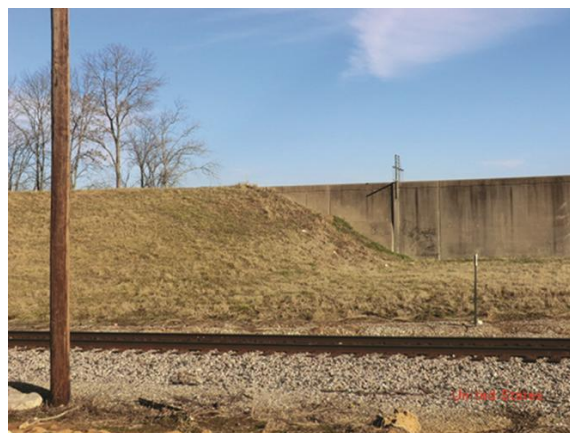
Figure 8.8 : Schéma et photographie illustrant la transition entre un tronçon de digue en remblai et un tronçon de digue en béton ou maçonnerie (appelé aussi mur anti-inondation) [8-1]
