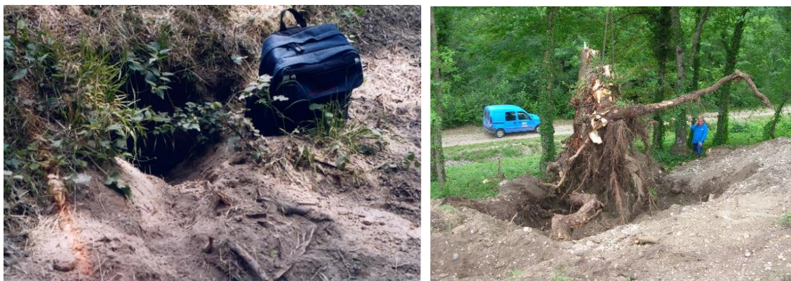
Figure 9.1 : Trou de terrier de blaireau à gauche (photo R. Tourment) et dégagement d'une souche de peuplier noir à Cusset (03) à droite [9-1]
