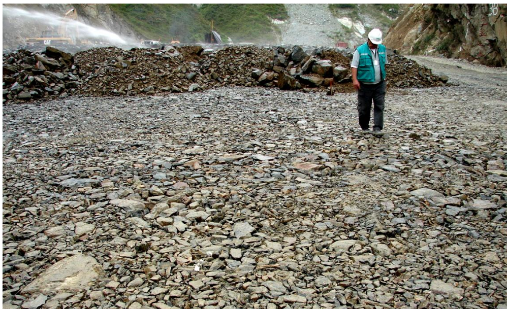
Enrochements compactés (construction du barrage de Mazar en Equateur)
