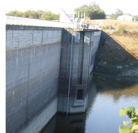
Tour de prise d'eau
