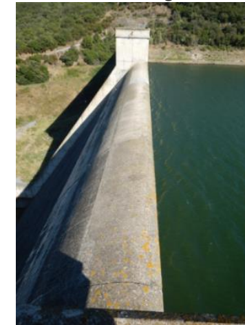
© Photo BEC pendant la construction
