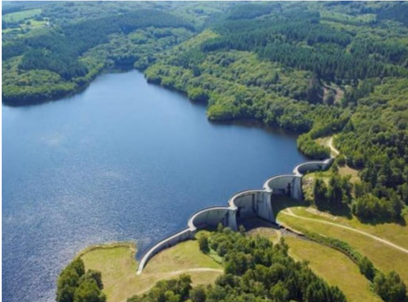
© Photo Service de l'eau Limoges Métropole
