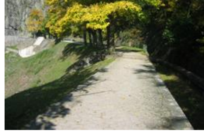
Photos EDF F. Delorme secondary spillway (2)
