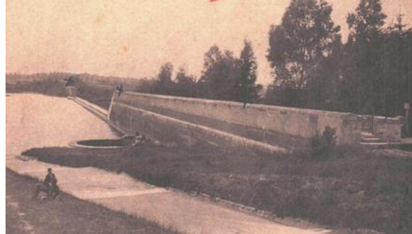
Vue du barrage reconstruit avec RN abaissée (1901-1939)
