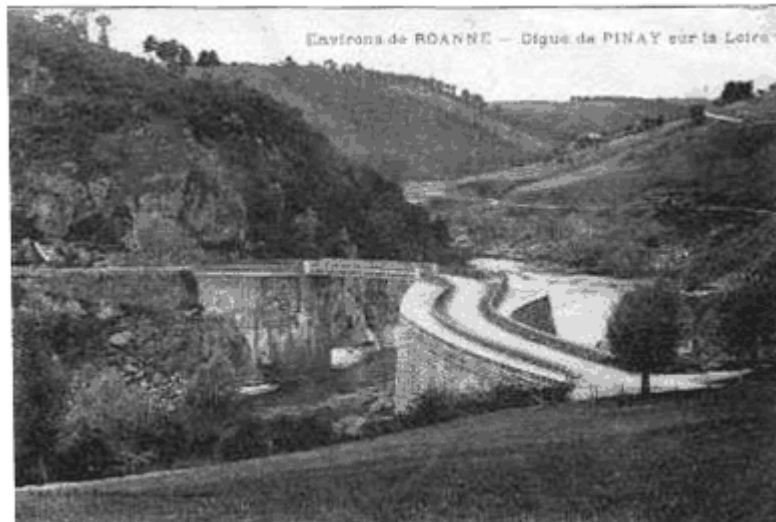
Figure 13 : Le barrage de Pinay
