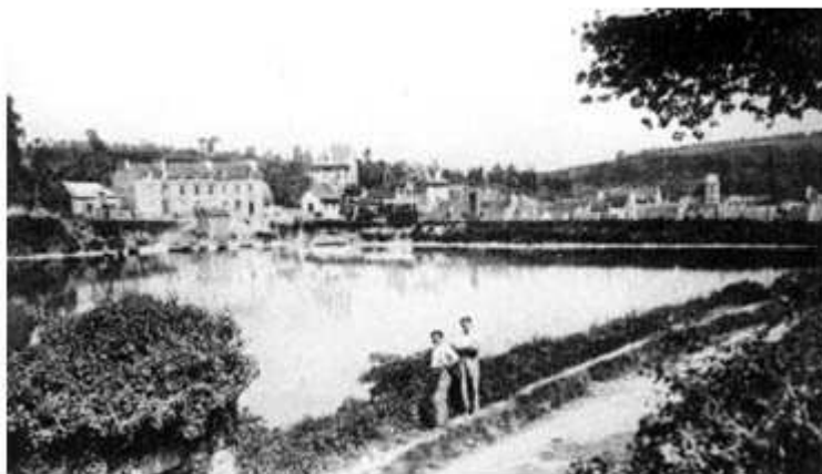
Figure10 : digue de Jugon (1230). Capacité de 2,8 millions de m 3 et hauteur de 8,5m. Sa finalité était de constituer un plan d'eau de défense du chateau, de faire tourner deux moulins et une forge et de permettre l'élevage du poisson
