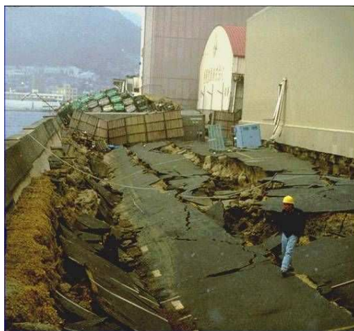
Figure 5-14 - Etalement latéral - Kobé
