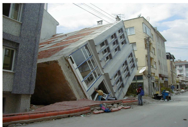
Figure 5-10 - Liquéfaction à Niigata (Japon 1964) et à Izmit (Turquie 1999)
