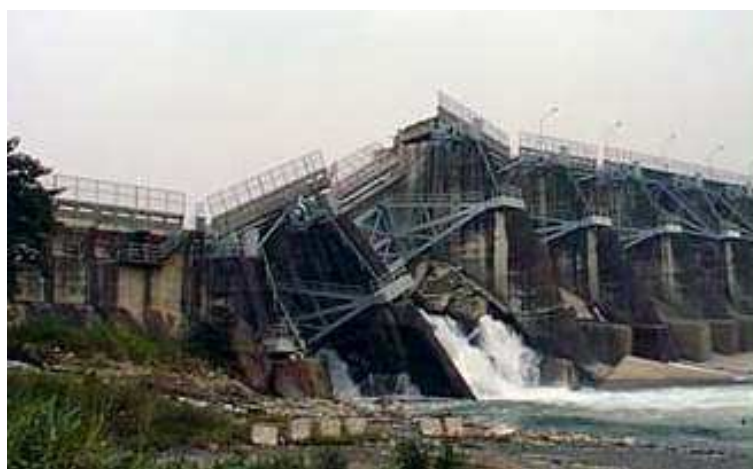
Figure 3-4 - Barrage de Shih-Kang après le séisme Chi Chi (Taïwan). – rupture au droit de la faille
