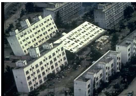
Figure 5-10 - Liquéfaction à Niigata (Japon 1964) et à Izmit (Turquie 1999)
