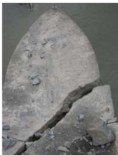
Figure 3-7 - Nez de pile d'un barrage en rivière suite à des chutes de pierres
