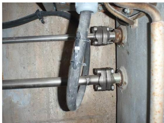
Figure 2.8 – Examen de l'état des raccords inox entre le vérin et la centrale oléo-hydraulique
