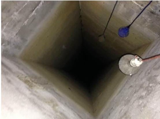
Figure 2.3 – Vérification de la position des poires d'alarme dans un puits
