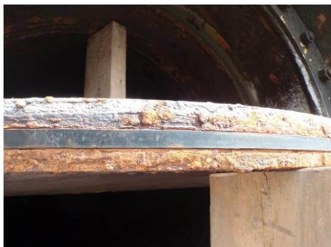
Figure 2.7 – Examen de l'état de la lentille d'une vanne papillon dans un conduit de vidange
