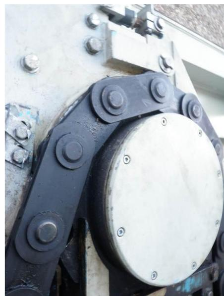
Figure 2.6 – Examen de l'état de la chaîne Galle de manœuvre d'une vanne d'évacuateur de crues
