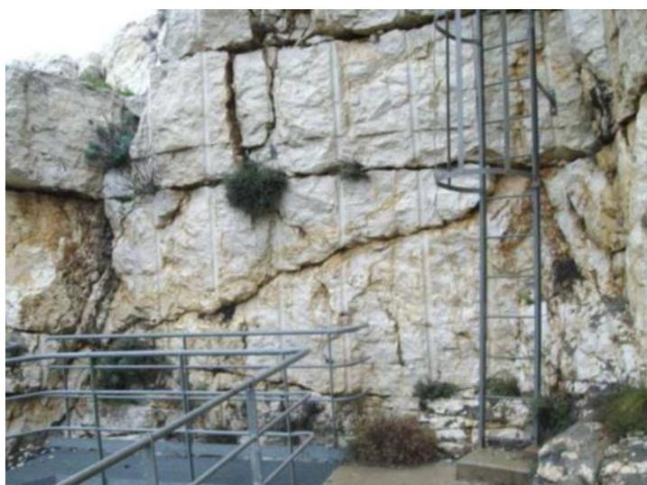
Figure 2.9 – Examen géologique de blocs instables sur l'une des rives du barrage
