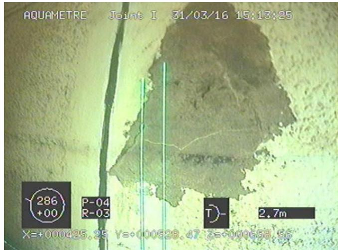
Figure 2.4 – Relevé par robot sous-marin de la dégradation de l'enduit d'étanchéité à proximité d'un joint amont
