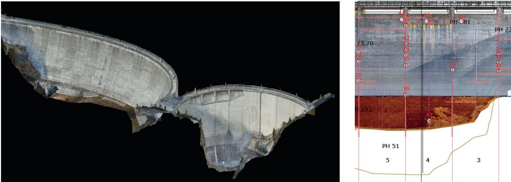
Pour des examens sans vidange de la retenue, l'emploi de robots sous-marins équipés de différents types de capteurs pour les inspections des structures et des organes hydromécaniques se systématisent. Ces inspections sont généralement complétées par un relevé bathymétrique de la retenue afin de suivre l'évolution de son état d'envasement.
