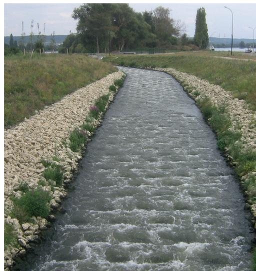
Cette rivière artificielle présente en aval un clapet de régulation pour maintenir une chute d'une vingtaine de centimètres garantissant l'attractivité de l'ouvrage. Ce clapet s'accompagne d'une rampe spécifique pour les petites anguilles (civelles) afin de faciliter leur passage.
