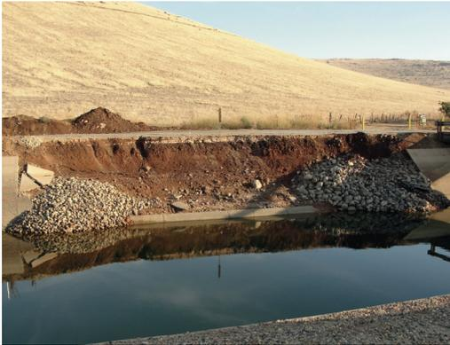
*Figure 7.10 – Canal de Friant Kern (USA, photo 2012) – Rupture type de la dalle de protection en béton de la berge due à la présence de sols gonflants / @ Lhoist*
