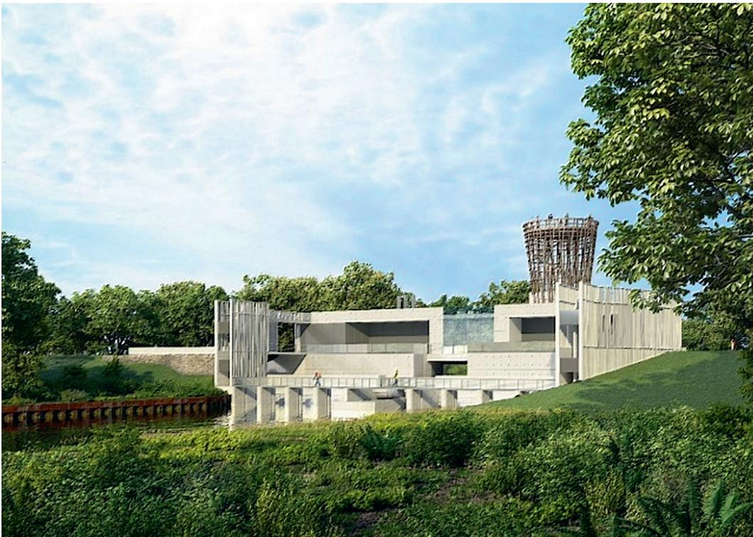
C'est l'option utilisée depuis quelques décennies par l'EPTB Seine Grands Lacs (cf. 2.2), avec des retenues en dérivation, alimentées par gravité. L'EPTB prolonge encore davantage cette piste, avec le projet de La Bassée, figure 1.18, dont l'objectif est un stockage temporaire du pic de crue.
