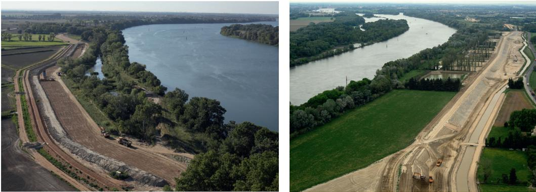
*Figure 9.2 – Réalisation d'une digue résistante à la surverse avec tous les composants nécessaires à sa sûreté et sa durabilité (étanchéité, filtration, drainage, évacuation des crues) / © Symadrem*
