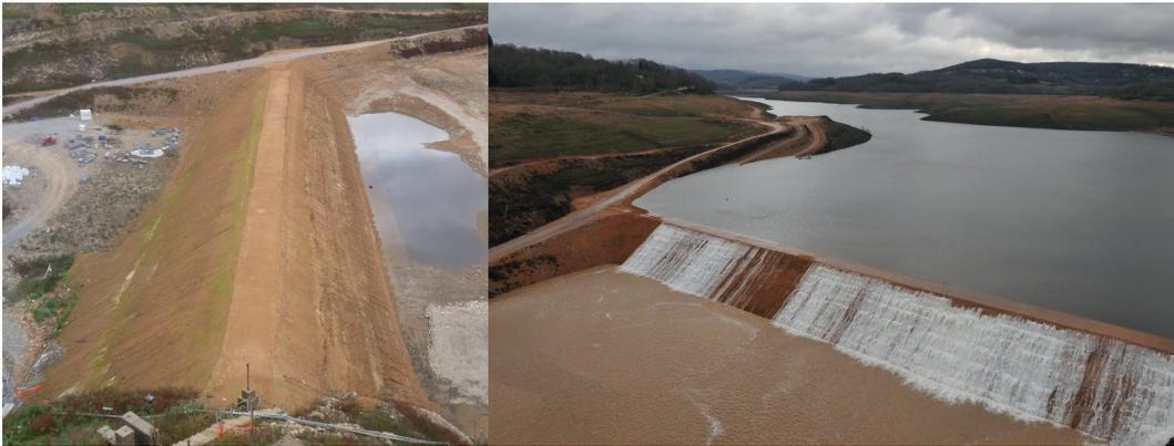
D'autres ouvrages significatifs plus anciens ont également eu recours au traitement des sols pour améliorer la maniabilité des matériaux et la stabilité. On peut citer le barrage de Fond Pignon (37,5 m – 1987–1990) constitué de craie traitée à la chaux, ou le barrage de Michelbach (22 m – 1982) dont le tapis d'étanchéité amont a été traité à la chaux.
