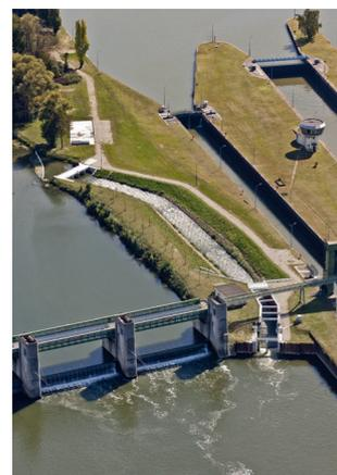
Figure 8.17 – Photos des macro-rugosités hors d'eau et en eau / © BRLi
