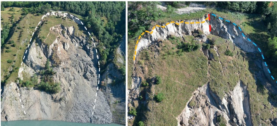
Cette expérience a par exemple été mise à profit en 2015 pour évaluer l'impact potentiel du glissement de la Berche dans la retenue du barrage du Chambon où, en partant du type de glissement, il a été possible d'évaluer la hauteur de la vague induite (figure 2.17 ci-dessus). Cette étude a fait l'objet d'une publication (Q102) lors du congrès de la CIGB de Vienne en 2018.
