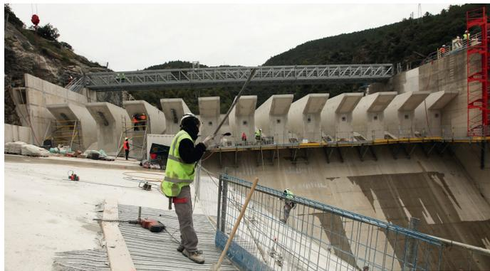
Figure 3.18 – PKW du barrage de Malarce / © EDF – T. Pinchard
