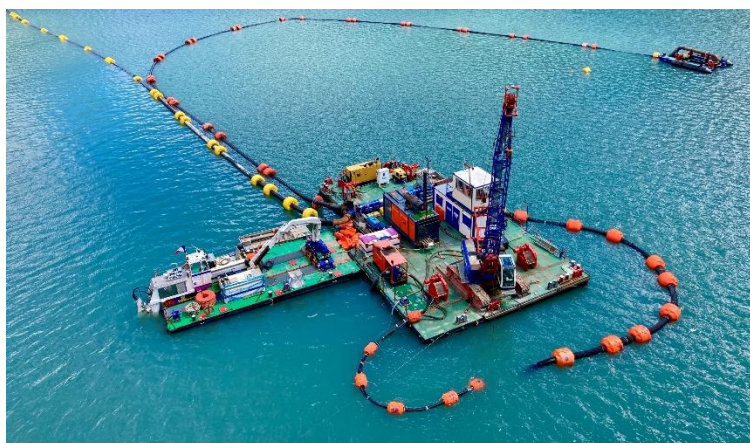
Figure 1 – Atelier de dragage et conduites de refoulement
