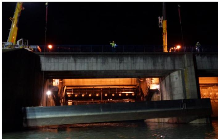
**Photo 11 :** Mise en place d'un élément du batardeau de GERSTHEIM par les grues
