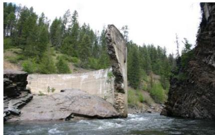
Mode 3 : Chargement au-delà des limites de résistance et instabilité (glissement, traction/fissuration) du barrage (en béton)
