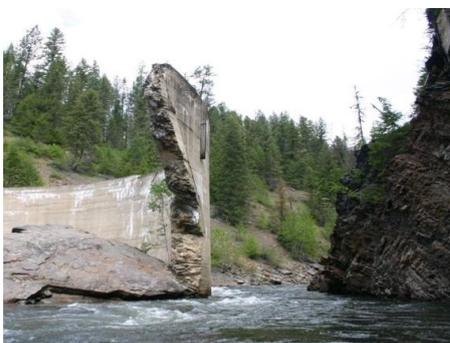
**Figure 7 :** Barrage Moyie Eileen (érosion de l'appui RG vue de l'aval)
