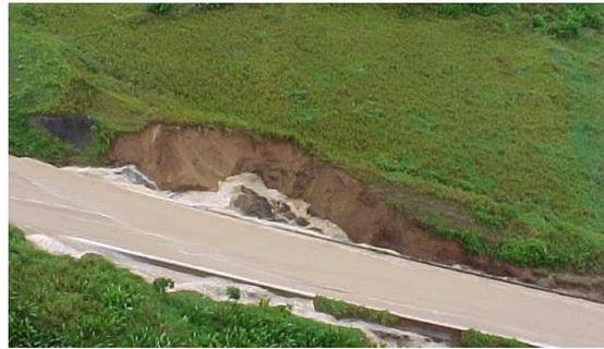
**Figure 9 :** Barrage El Guapo. Phase 2 : amorce de l'érosion de la fondation du coursier
