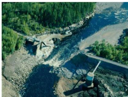
Mode 2 : Surverse et érosion des appuis RG et/ou RD et/ou de la fondation en pied
