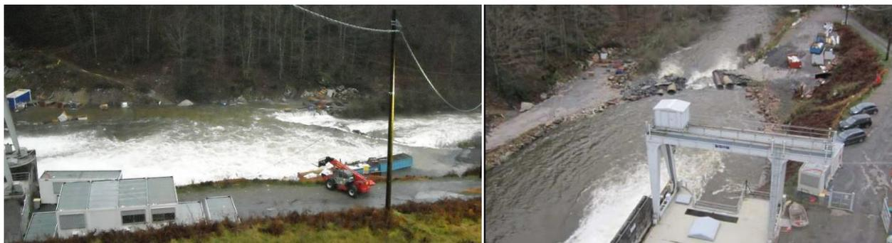
**Photos 12, 13 & 14 :** Vue du passage busé à l'aval du barrage avant, pendant et après la crue
