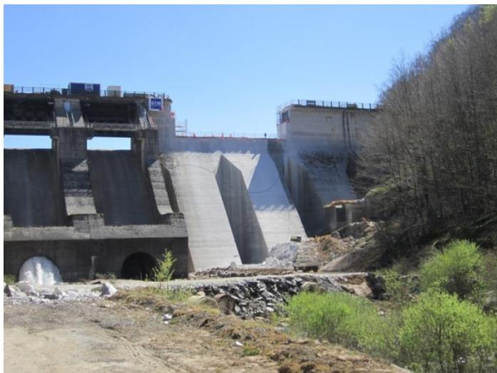
**Photo 15 :** Vue de l'ouvrage après réalisation de l'échancrure – Vannes EVC consignées ouvertes
