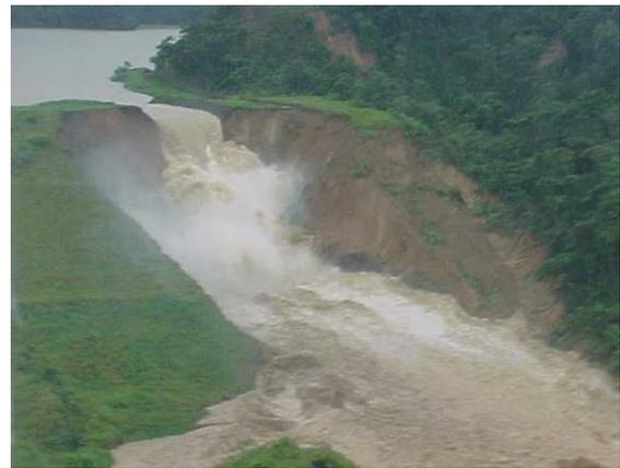
**Figure 10 :** Barrage El Guapo. Phase 3 : développement de l'érosion régressive et ruine de l'ouvrage
