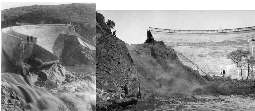
**Figure 7** : Barrage de Sweetwater. Erosion de l'appui RD.
