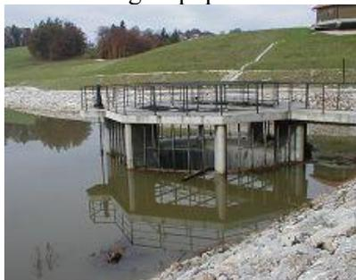
**Figure 2 :** Barrage de Drtijsica (Slovénie) : plan d'eau permanent contrôlé par une prise «tulipe»
