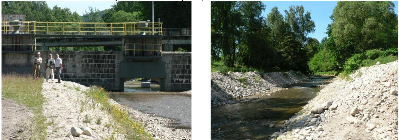
**Figure 14** : Barrage à pertuis ouvert de Myslakowice (PL) : à gauche : vue du parement amont; à droite, photo prise du même point en regardant vers l'amont : sédiments grossiers résiduels dans la cuvette. La comparaison entre le pertuis et les dimensions du lit montre que l'on se trouve en situation de « pertuis étroit ».
