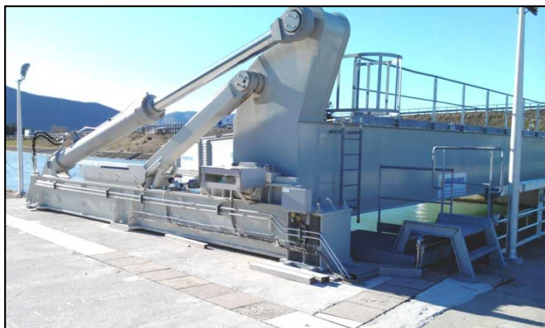
Installation de vannes d'isolement du canal d'Oraison | 12/2015
