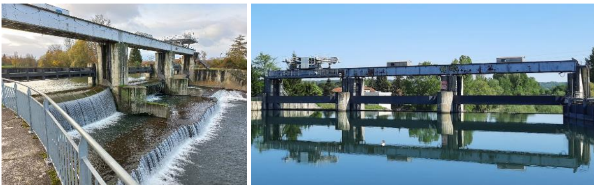
Figure 1 : Barrage de Rodère avant travaux
