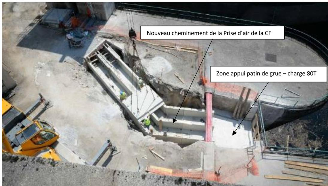
Figure 3 : construction du conduit de la prise d'air de la CF de l'usine de St Pierre – juin 2015
