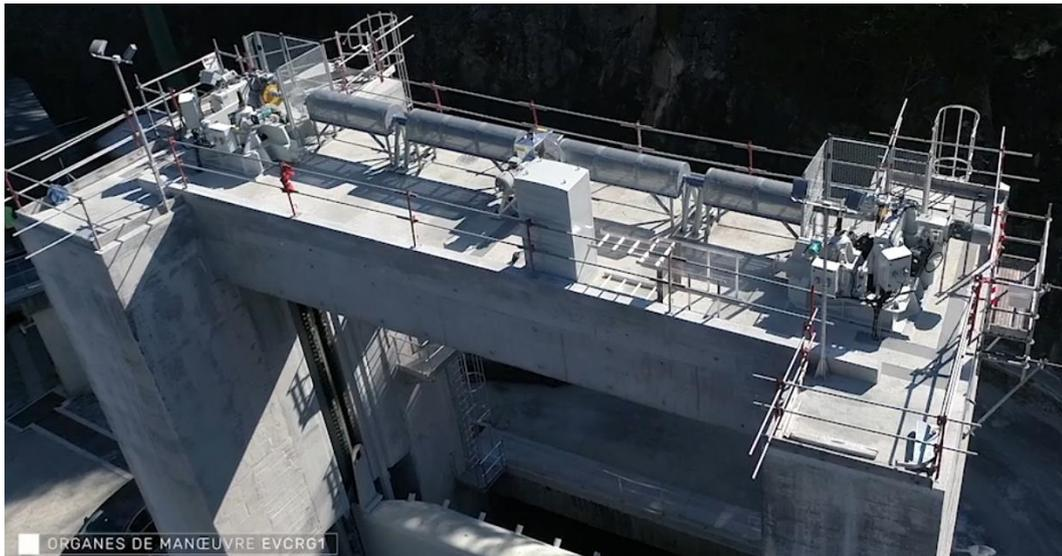
Figure 8 : Motorisation de la vanne EVCRG1
