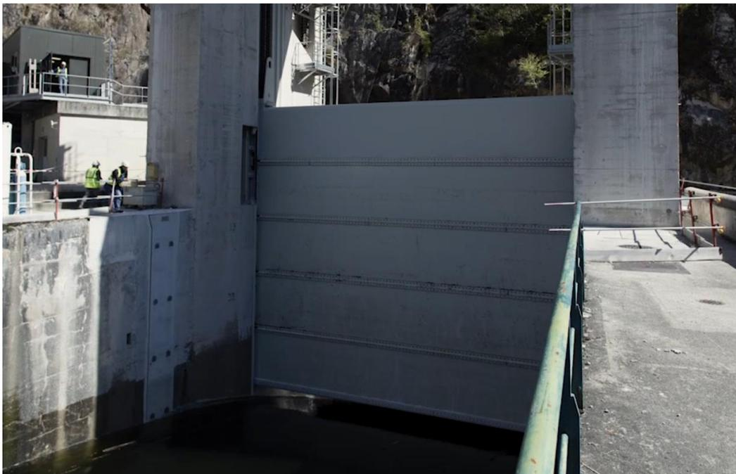
Figure 9 : Essai d'ouverture de la vanne EVCRG1 en charge –  $Q$  évacué =  $450\text{m}^3/\text{s}$
