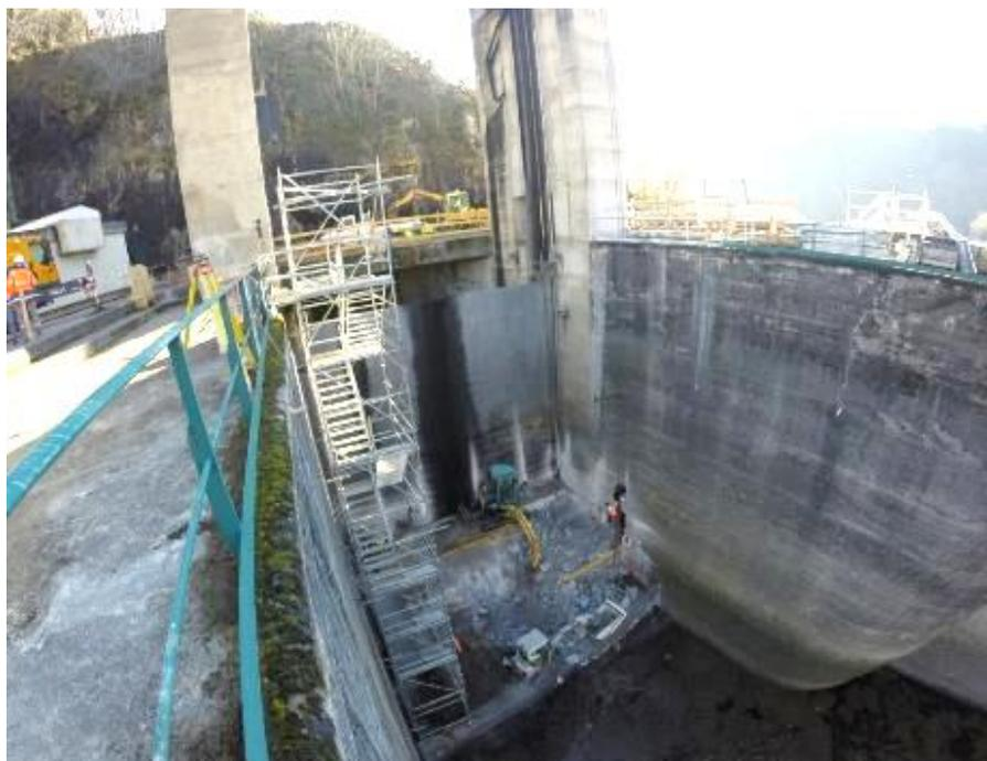
Figure 4 : Atelier de déroctage sur le seuil de la vanne EVCRG1
