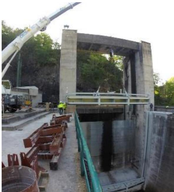
Figure 5 : Grutage des éléments du batardeau dans les rainures - EVCRG1 - 17 mai 2016
