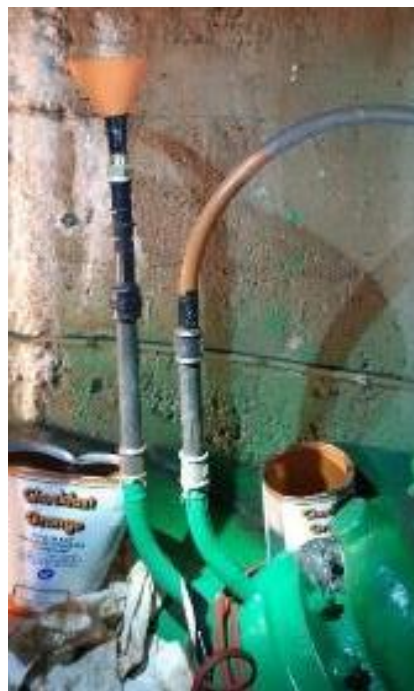
Figure 23-Vue du dispositif d'injection de la résine avec le point d'injection à gauche et l'évent à droite
