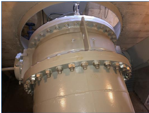
Figure 24- Vue d'amont du corps de la vanne renforcé et repeint
