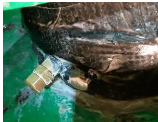
Figure 9- Application d'une fibre de carbone sur le piquage amont
