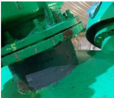
Figure 8- Application de la résine céramique sur le piquage aval
