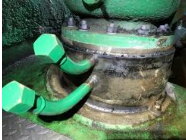
Figure 22- Résultat final de la coque soudée sur le piquage amont
