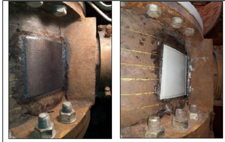
Figure 7 : Mise en place du patch composite sur la perforation
