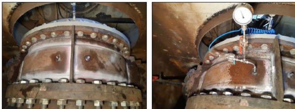
Figure 19 : Réalisation des contrôles par ressuages et des tests d'étanchéité des soudures
