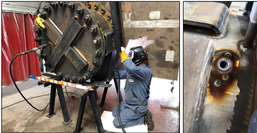
Figure 14 : Essais de soudage d'une doublante inférieure sur la maquette et essais de percement
