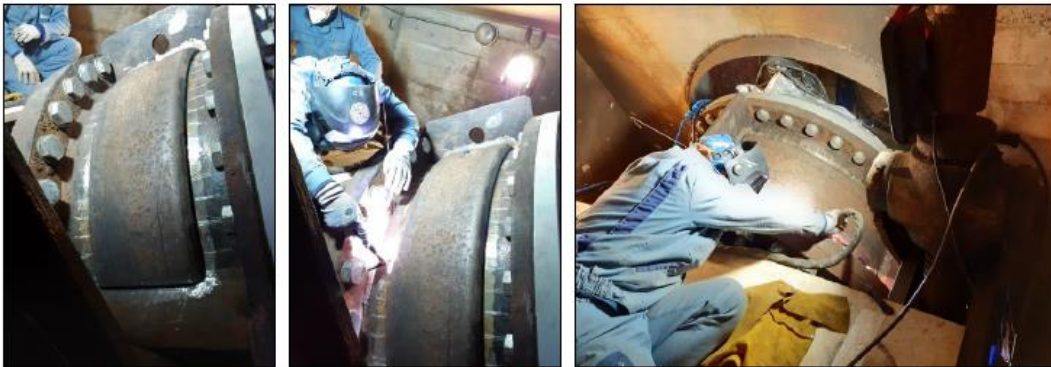
Figure 18 : Soudage sur site des doublantes de renforcement
