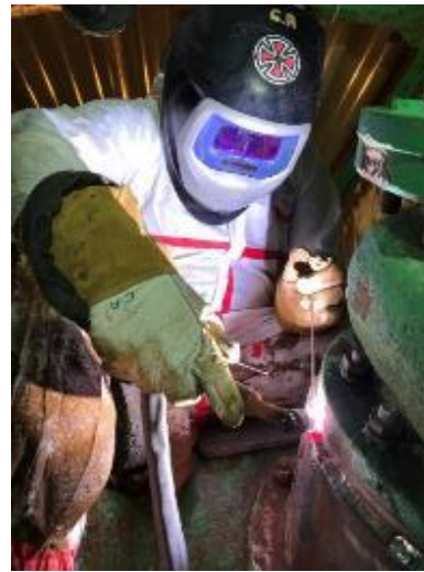
Figure 21- Le soudeur en action sur la soudure de fermeture, contraignante pour le piquage
