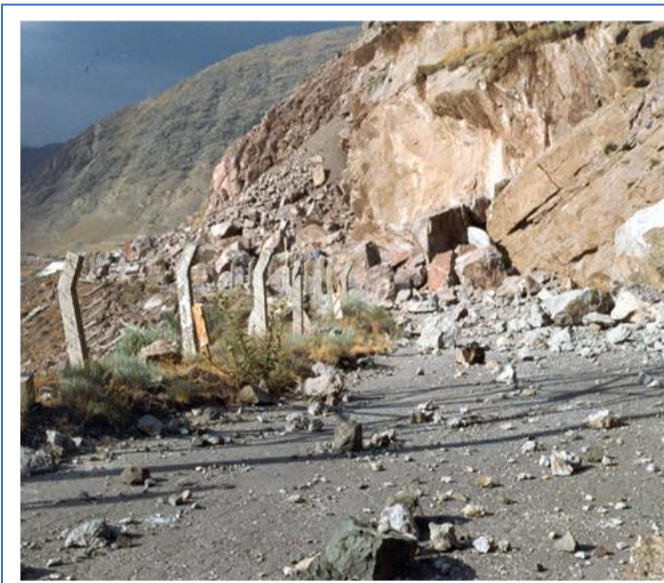
Figure 4 : route d'accès au barrage détruite
