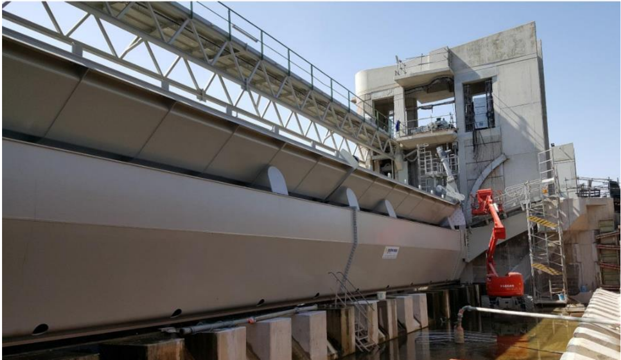
Figure 2 : ensemble vanne segment – clapet de surverse depuis l'aval du barrage © VNF
