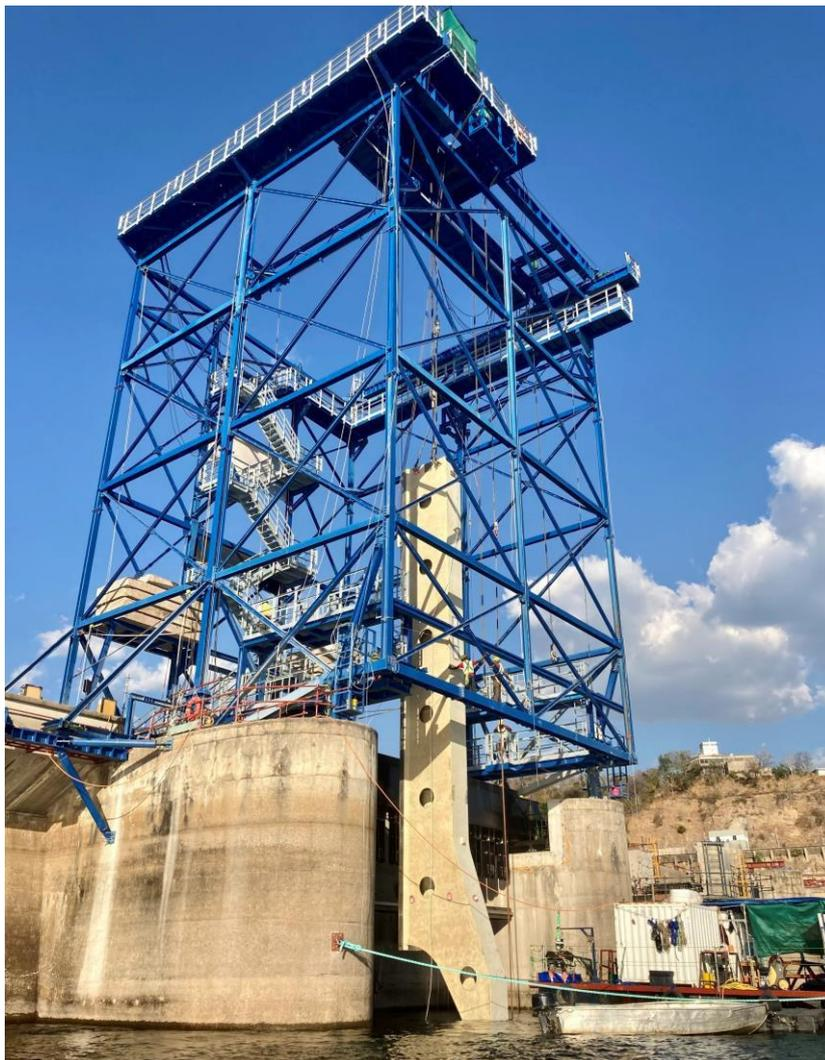
Figure 14 : Portique de chantier manutentionnant une demi-aiguille de 20 t sur le barrage de Kariba (Zambie-Zimbabwe)
