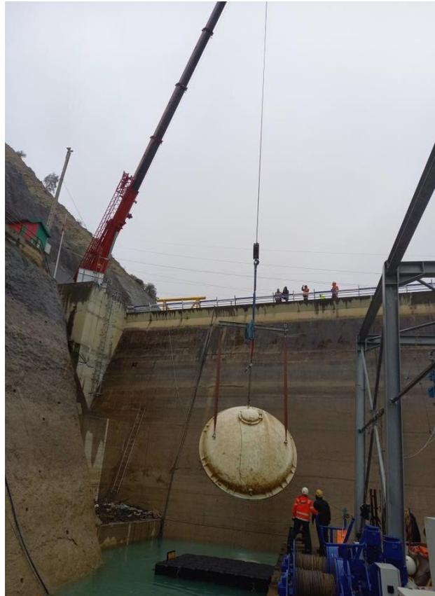
Figure 1 : Retrait par grue de l'obturateur de 4,5 m de diamètre sur le barrage Idriss I<sup>er</sup> (Maroc)
