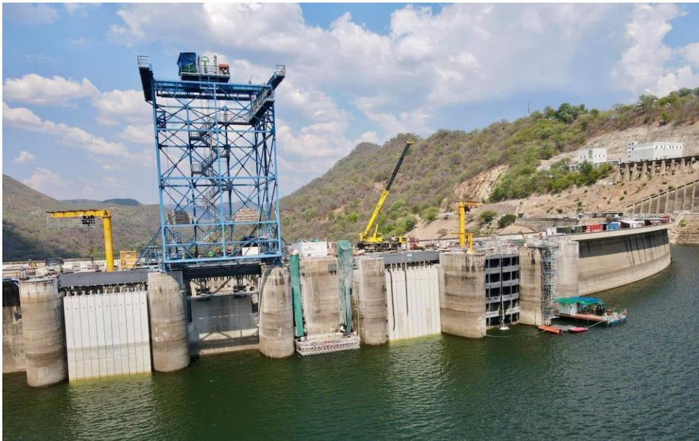
Figure 3 : Aiguilles de batardage de 35 m de haut installées sur deux pertuis d'évacuateur de crue du barrage de Kariba (Zambie-Zimbabwe)
