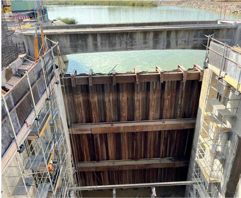
Figure 4 : Rideau de palplanches H\*L = 15 m x 12 m sur l'évacuateur de crue du barrage de Laroussia (Tunisie)
