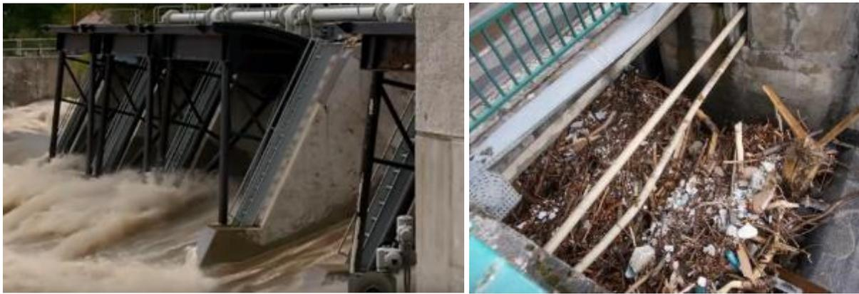
Figure 13 : a) Rupture d'une vanne segment au barrage de Black River (USA, 2016), Déformation d'un arbre de synchronisation lors d'une crue (France, 2013)
