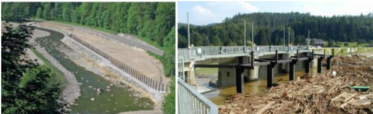
Figure 15 : Exemple de système de rétention a) peigne, b) masque amont (râtelier ou « visor »)
