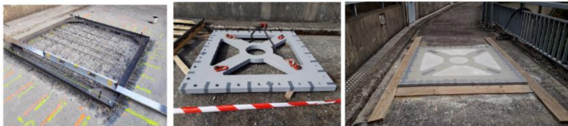
Figure 13 : Photos des travaux de scellement de la platine fixe
