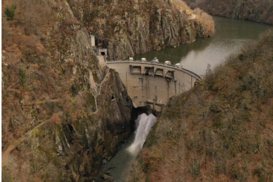
Figure 1 : Vue du barrage de La Barthe
