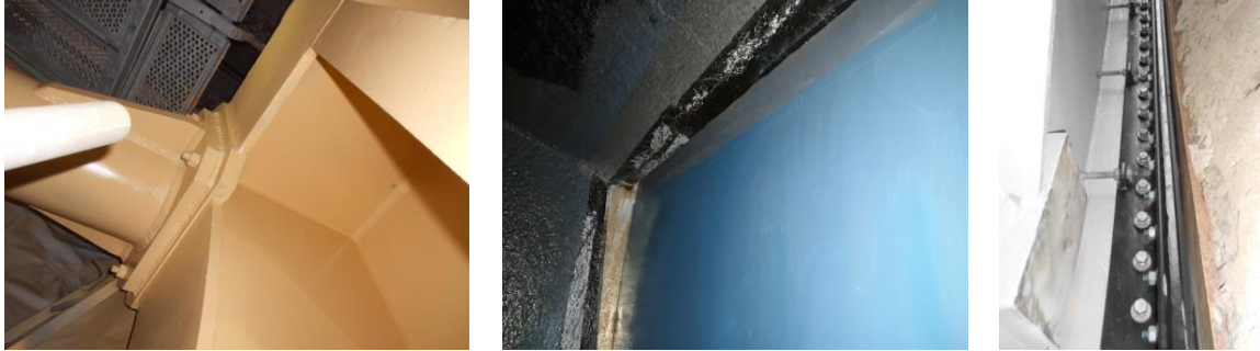
Figure 20 : Vue des travaux réalisés (revêtement de peinture structure vanne, revêtement bordé amont, étanchéités)
