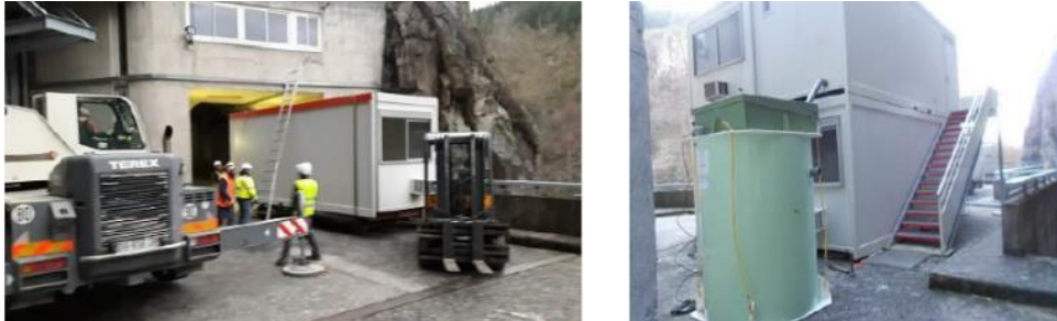
Figure 15 : Photos des travaux d'installation de la base vie
