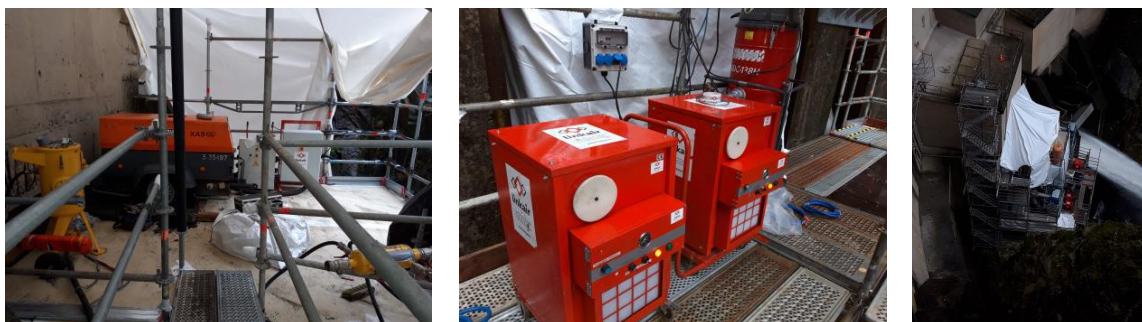
Figure 19 : Vue des moyens logistiques des travaux d'application de peinture (confinement, aérothermes)
