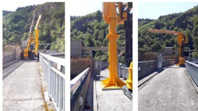
Figure 14 : Photos des travaux de montage de la potence
