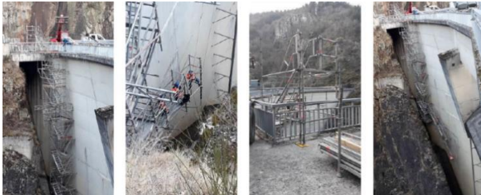
Figure 16 : Photos des travaux d'installation de l'échafaudage d'accès
