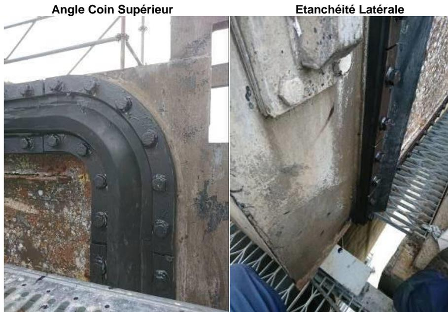
Figure 4 - Travaux réalisés sur les étanchéités
