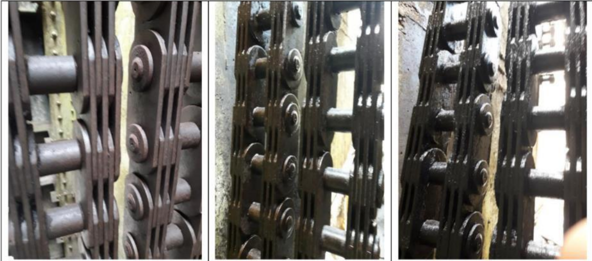
Après Nettoyage par cryogénie (opérations réalisées chaînes en place)
