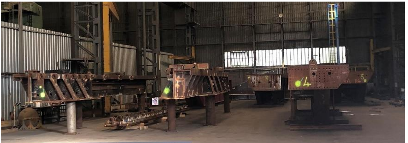
Figure 2 : éléments stoney posés dans un second hall chez CMP
