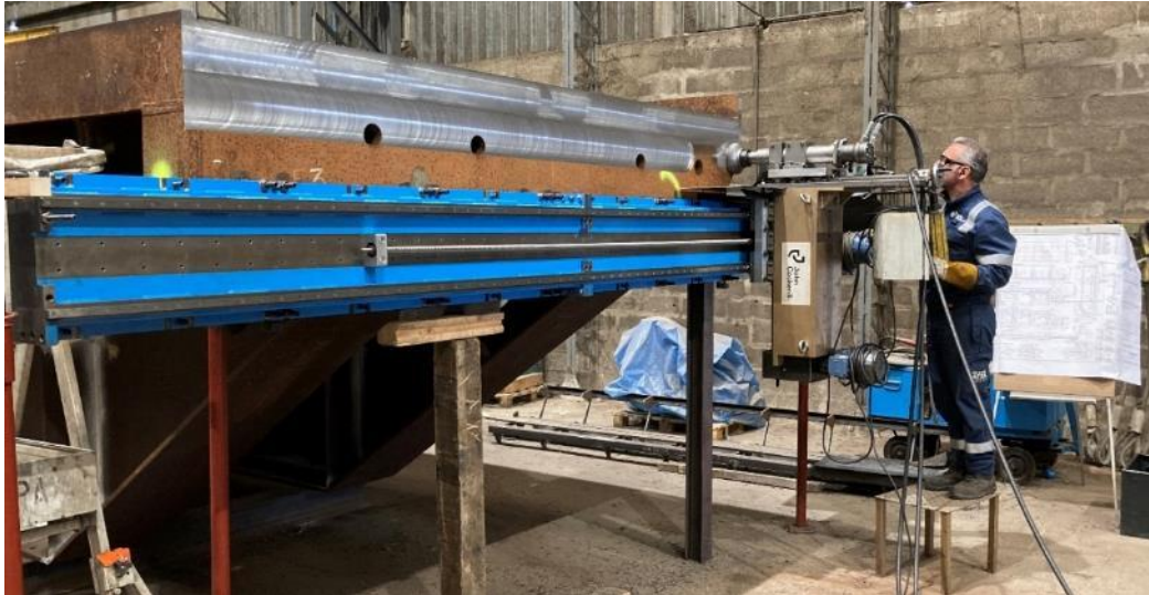
Photo 5 : dressage d'une face latérale de l'élément stoney n°3: en bleu le banc de guidage avec la vis d'avance ; à droite la fraise actionnée par un moteur hydraulique
