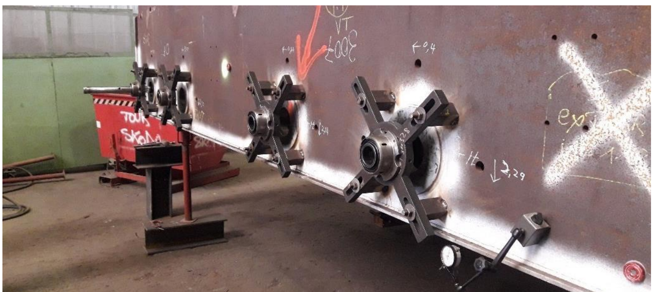
Figure 5 : mise en place des guides d'alésoirs pour les bossages extérieurs des galets de la vanne wagon
