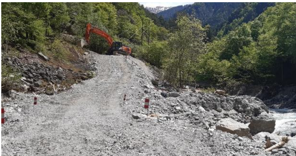
Figure 7-Vue de la remise en état de la piste d'accès
