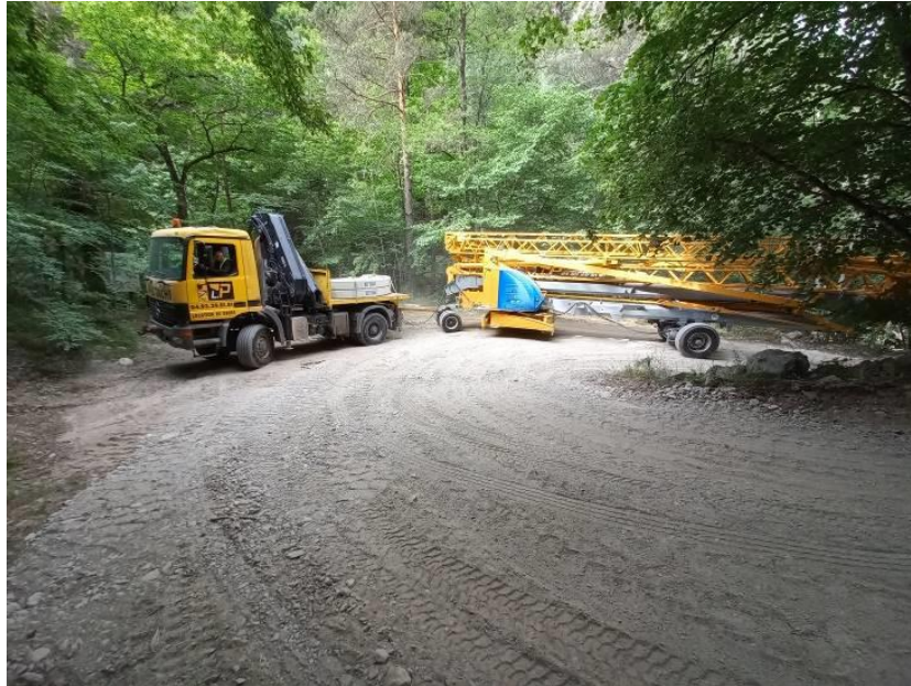
Figure 8-Vue du convoi de la grue sur la piste réaménagée à l'occasion
