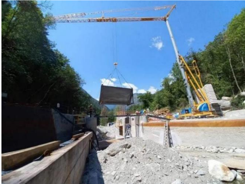
Figure 11-Manutention du bordé de la vanne segment V1 sur son châssis
