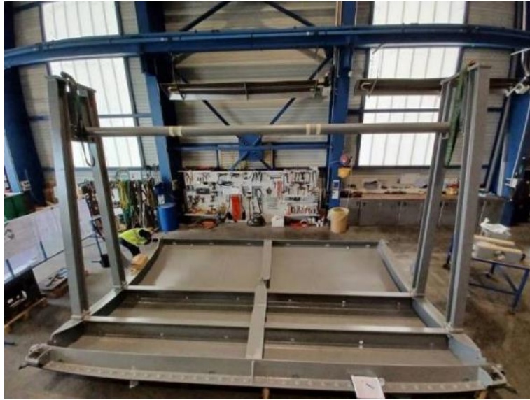
Figure 6-Montage à blanc du bordé et des bras de la V1
