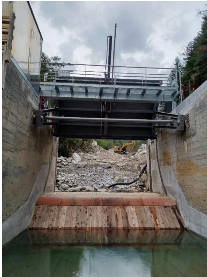
Figure 13- Vue de la vanne ouverte avec sa passerelle de support de la manœuvre et ses pièces fixes de seuil
