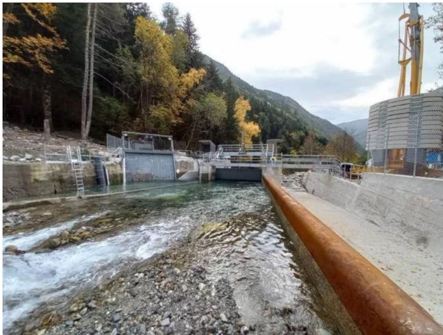
Figure 14- Remise en eau de l'aménagement
