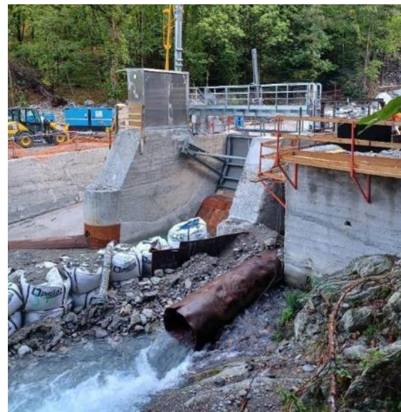
Figure 10- Vue en aval de la mise à sec de la passe V1
