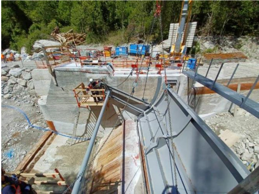
Figure 12-Assemblage des bras sur le bordé sur site
