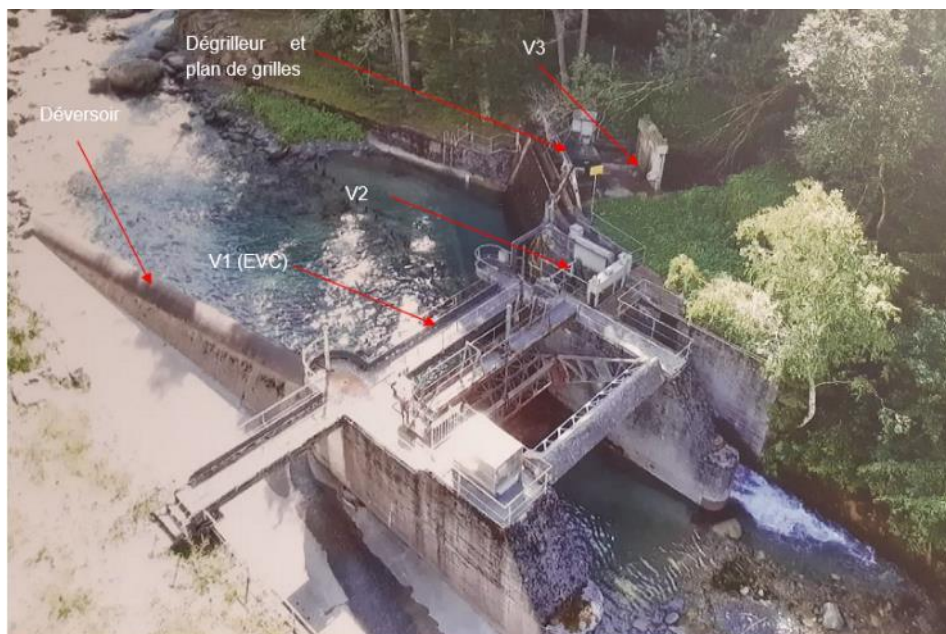
Figure 1- Vue aérienne de la prise d'eau de Mollières avant la tempête Alex
