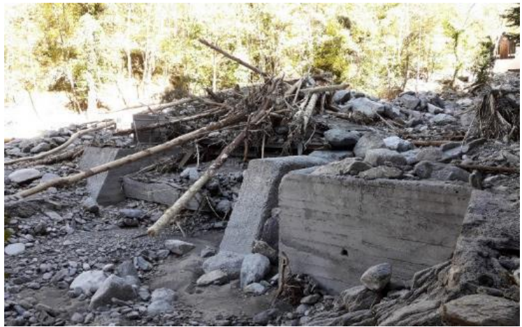
Vue depuis l'aval RG de la prise d'eau
