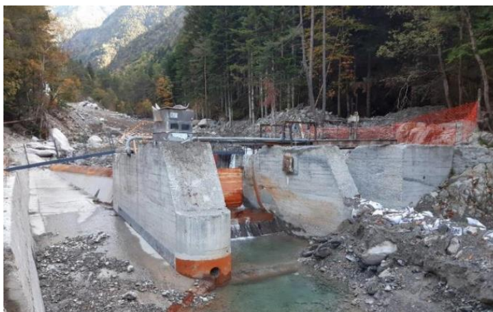
Figure 4-Résultat final du dégravement de la Prise d'Eau sans la vanne V1
