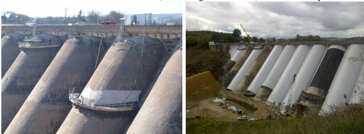
Figure 4 : Moyens d'accès au parement amont : nacelles autoélevatrices (à gauche), et échafaudages
