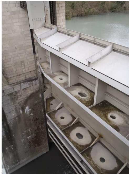
Figure 2 : Exemple de vannes EVC doubles concernée par l'expérimentation Vanne supérieure abaissante de type wagon et vanne inférieure Stoney
