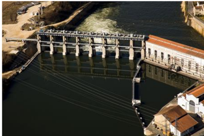
Figure n°1 – Vue amont du barrage de Tuilières
