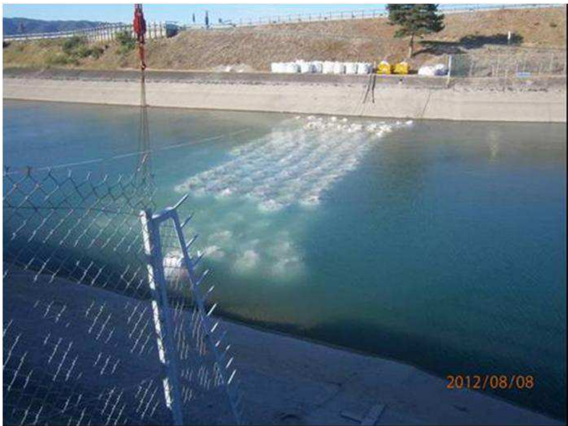
Graphique 9 : photo de la mise en place de l'avant dernier lit de bigs-bags
