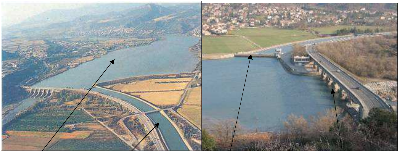
Retenue de l'Escale Canal d'Oraison Prise d'eau du canal d'Oraison Barrage mobile
