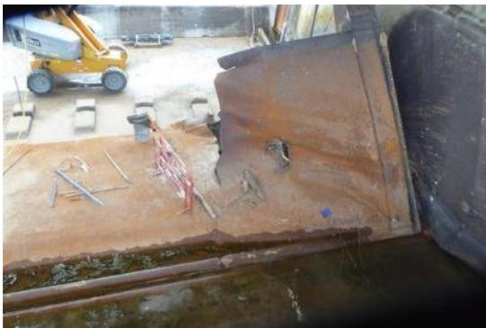
Figure 1 : Rupture d'un clapet le 28/06/2021. Crédit : Dominique LENNE- DREAL Aura
