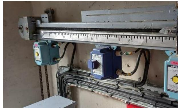
Echelle limnimétrique et réglotte de position d'une vanne de surface – Barrage de La Barthe (photos PoNSOH)
