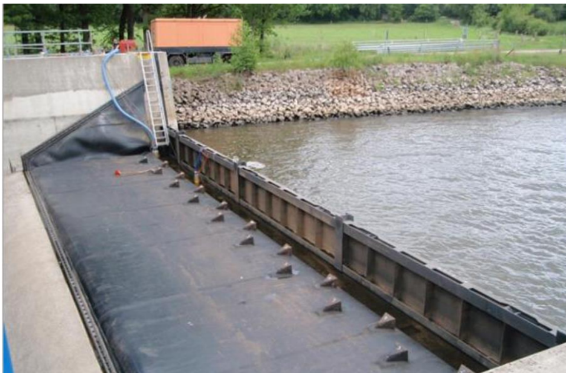
Figure 7 : mise à sec d'une passe pour inspection de la membrane, barrage de Bannetze, Allemagne, © BAW
