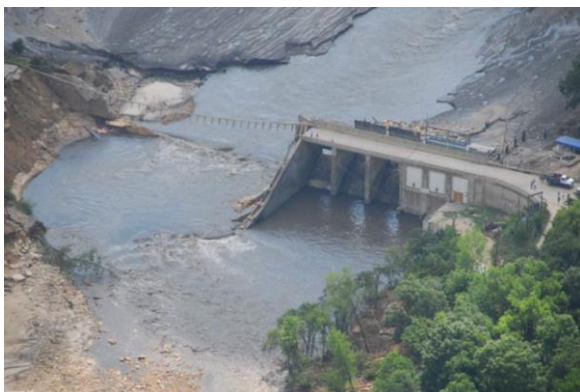
Figure 5 : Vue générale du barrage du lac Delhi, États-Unis (2010) après rupture
