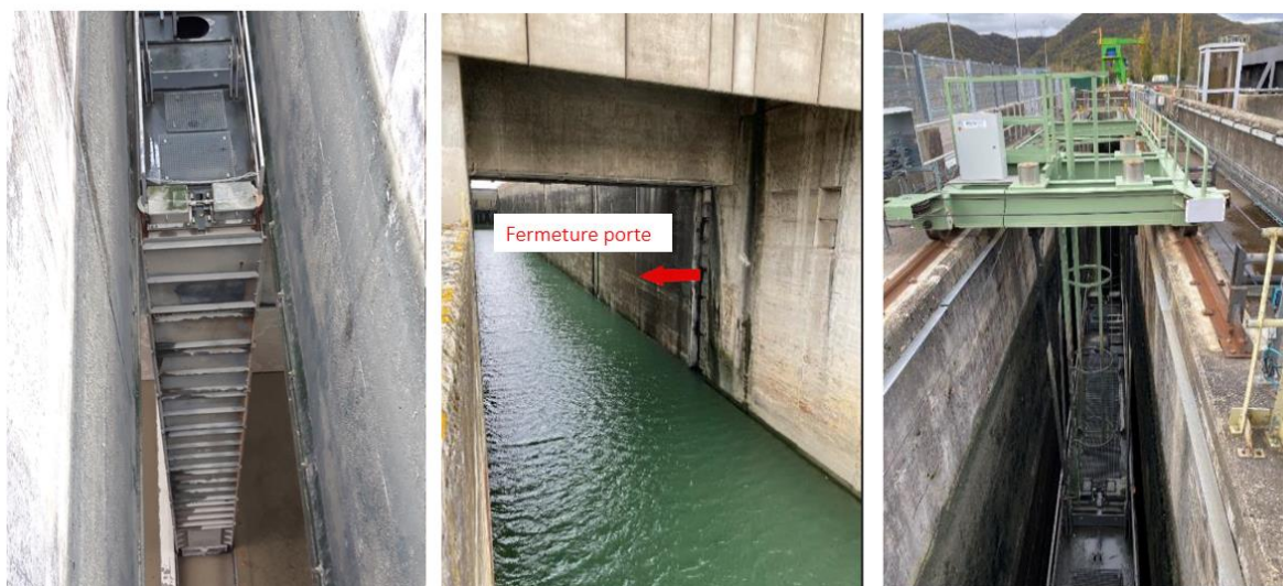
Figure 1 Photo porte d'origine – Ecluse de Sablons
