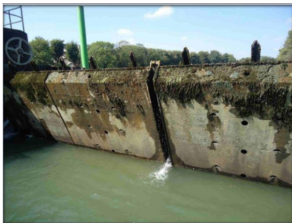
Figure 10 : détail clapet relevé et brises lames
