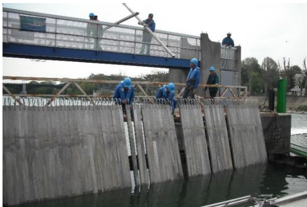
Figure 5 : Pose d'aiguilles au sein du pertuis, rive gauche
