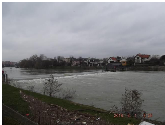
Figure 8 : en début de crue, barrage en cours d'effacement
