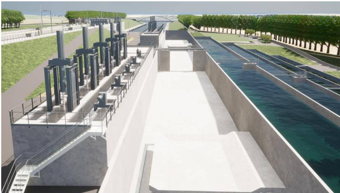
Figure 5 : Maquette BIM -ONE: Vue sur la « tulipe » d'un bassin d'épargne et son toit et émergences des organes de manœuvre.
