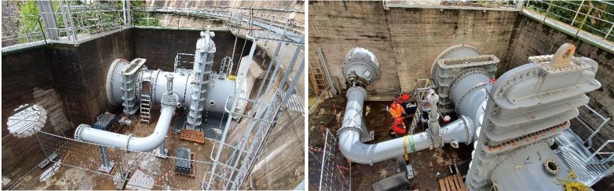
Figure 21 - Montage des éléments servant au transit du débit réservé (photos EIFFAGE)
