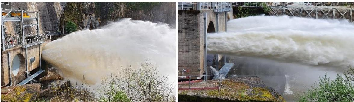
Figure 23 - à g. Jet de la vanne papillon originale versus à dr. Jet de la vanne jet-flow à débit identique (photos EIFFAGE)
