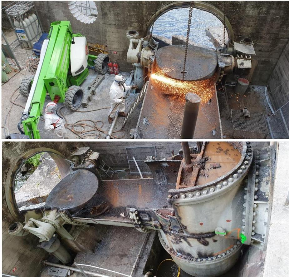
Figure 17 - Aperçu du découpage des vannes de la file rive droite en contexte amiante (photos EIFFAGE)
