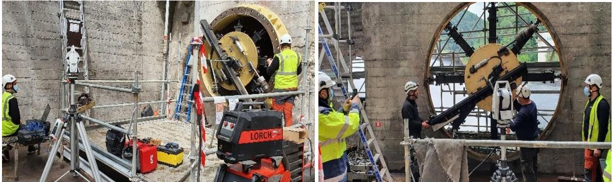
Figure 19 - Opération d'usinage sur site de la file rive droite - bride amont - bride aval (photos EIFFAGE)
