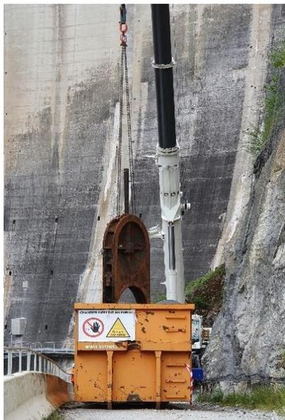
Figure 18 - Obturateur d'origine avant évacuation (photo EIFFAGE)
