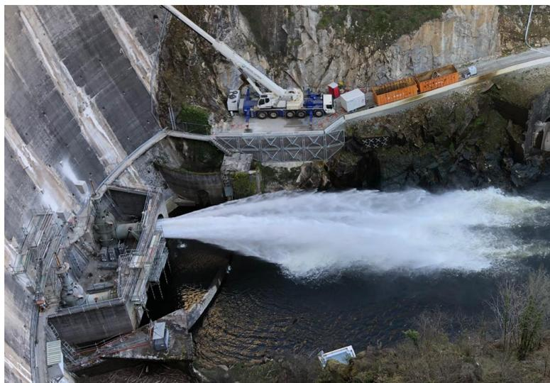
Figure 15 Aperçu de la plateforme de levage alimentant le chantier (image SHEM)
