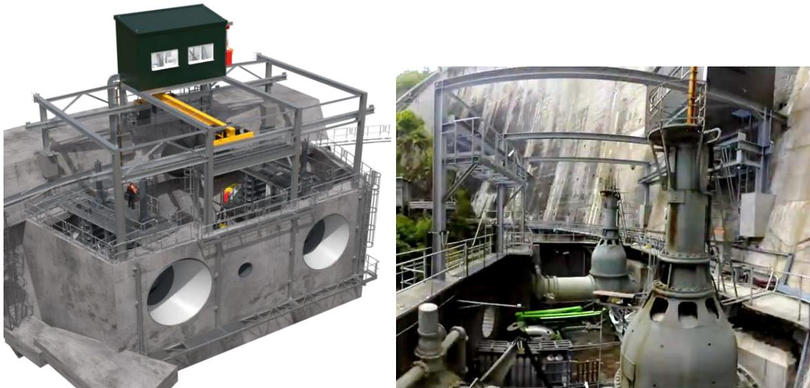
Figure 16 - Conception puis réalisation de la structure de levage au-dessus de la chambre (images EIFFAGE et photo SHEM)
