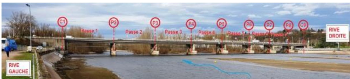
Figure 1: Vue du barrage de Vichy depuis l'amont (Source : BRLi)
