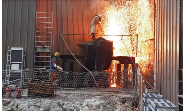
Figure 16 : Travaux de découpe de l'ancienne vanne
