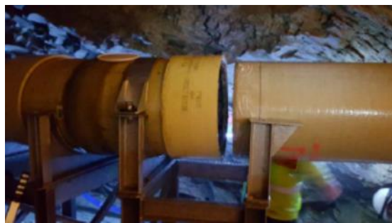
Figure 11 : assemblage de la conduite PRV
