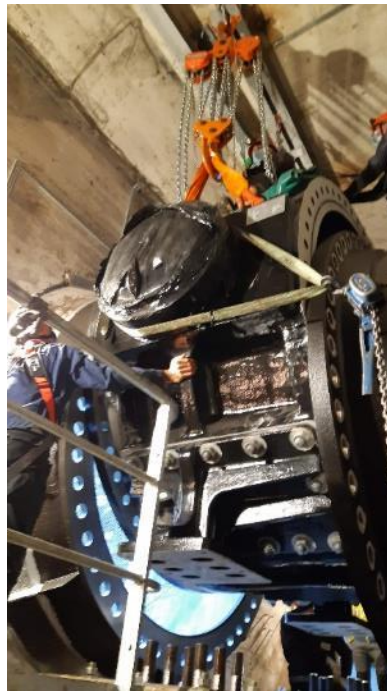
Figure 18 : insertion de la nouvelle vanne RG entre brides
