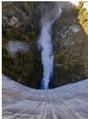
Figure 19 : vue des essais avec lâcher d'eau depuis le couronnement du barrage
