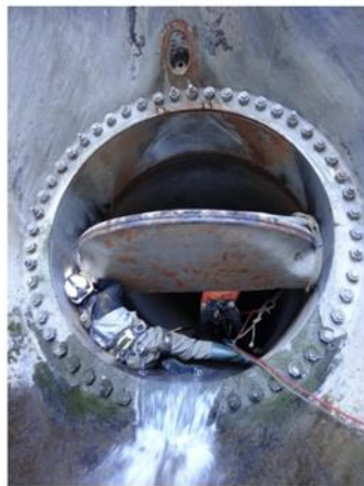
Figure 3 : vue aval d'une vanne papillon d'origine, lors d'une intervention sur site
