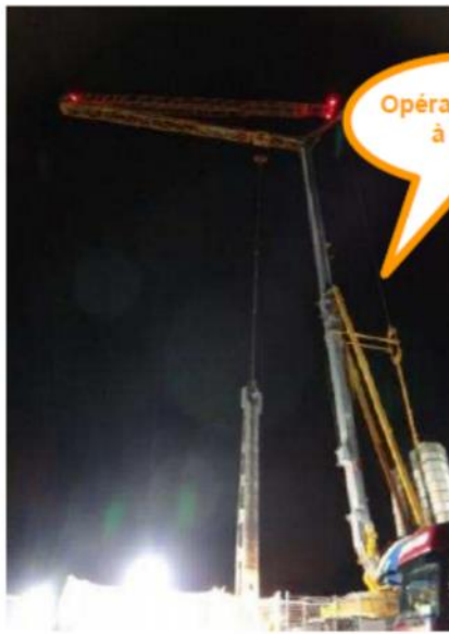
Figure 7 : Extraction des brimballes de nuit, pour réduire les interférences routières
