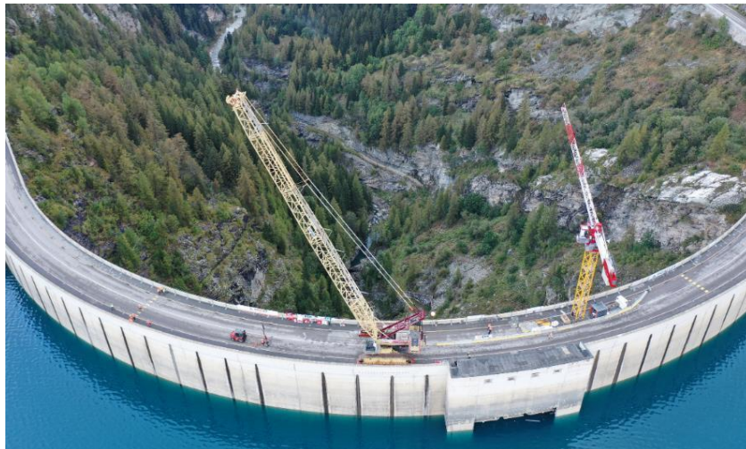
Figure 15 : photo aérienne prise lors de manutention des vannes papillons avec la grue 650 T
