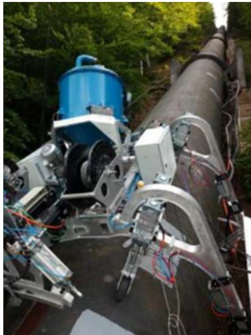
Figure 1 : conduite forcée de La Coche – robot de décapage
