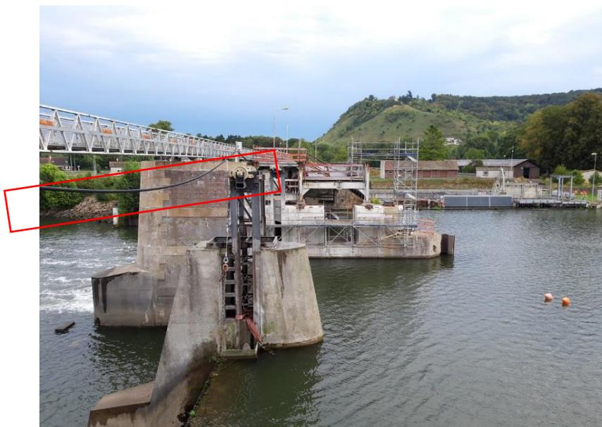
Figure 9 : Pont déposé et réseau provisoire d'alimentation électrique (entouré en rouge)
