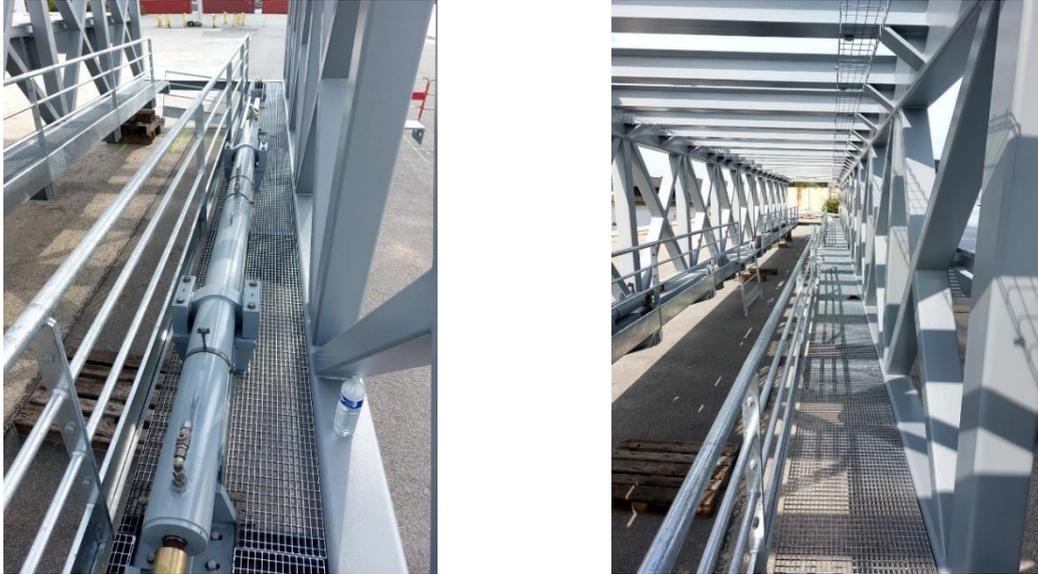
Figure 11 : Equipement à quai du pont – vérins à gauche et chemin de câble à droite
