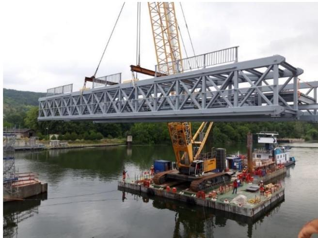
Figure 10 : Pose du pont en une seule opération
