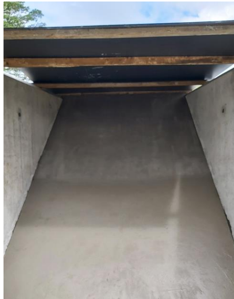
Figure 7. Construction d'un module de Fusegate®
