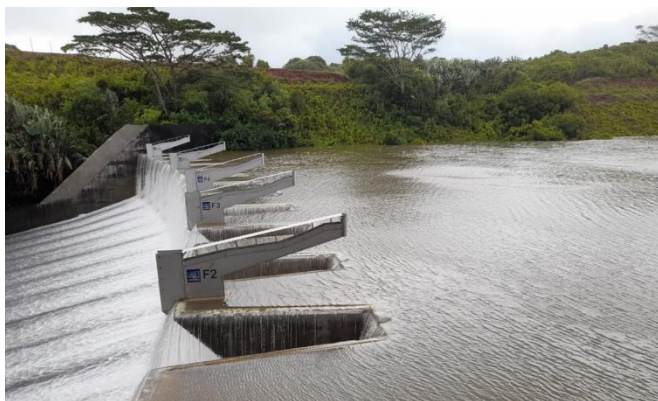
Figure 11. Exploitation du déversoir quelques semaines après l'achèvement du projet
