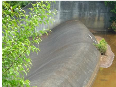
Figure 1. Vue amont du déversoir
