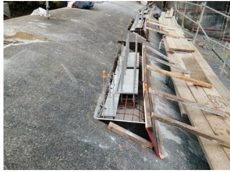
Figure 5. Préparation du déversoir
