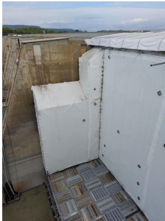
Figure 9 - Echafaudage de pied, complet avec confinement – Caderousse V1 Août 2022
