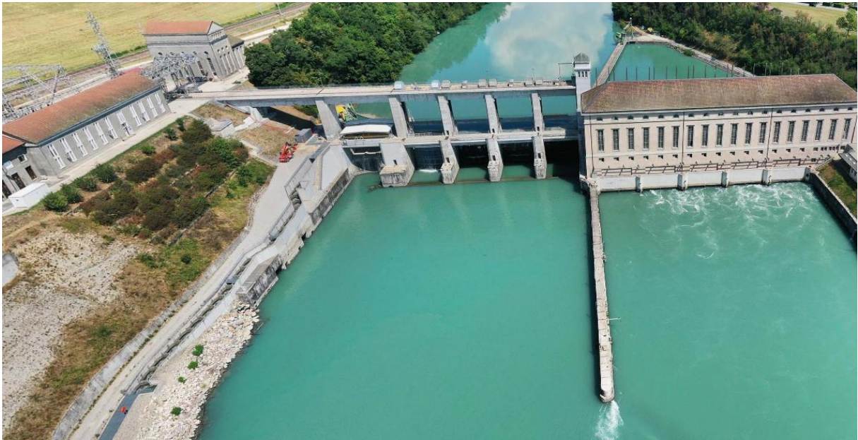
Figure 1 - Vue aérienne de l'aménagement
