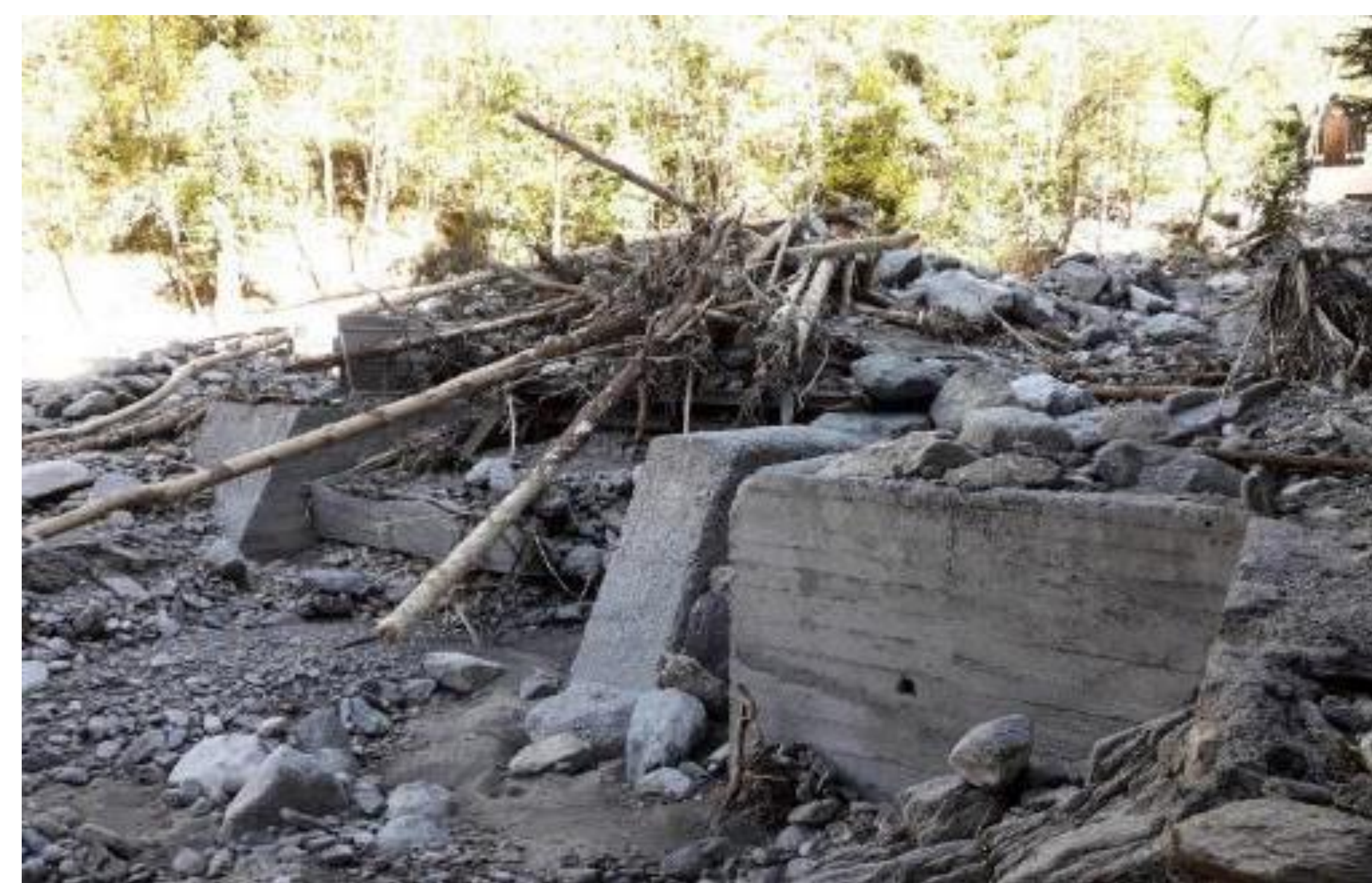
Engravement Vanne V1 - Vue depuis l'aval
