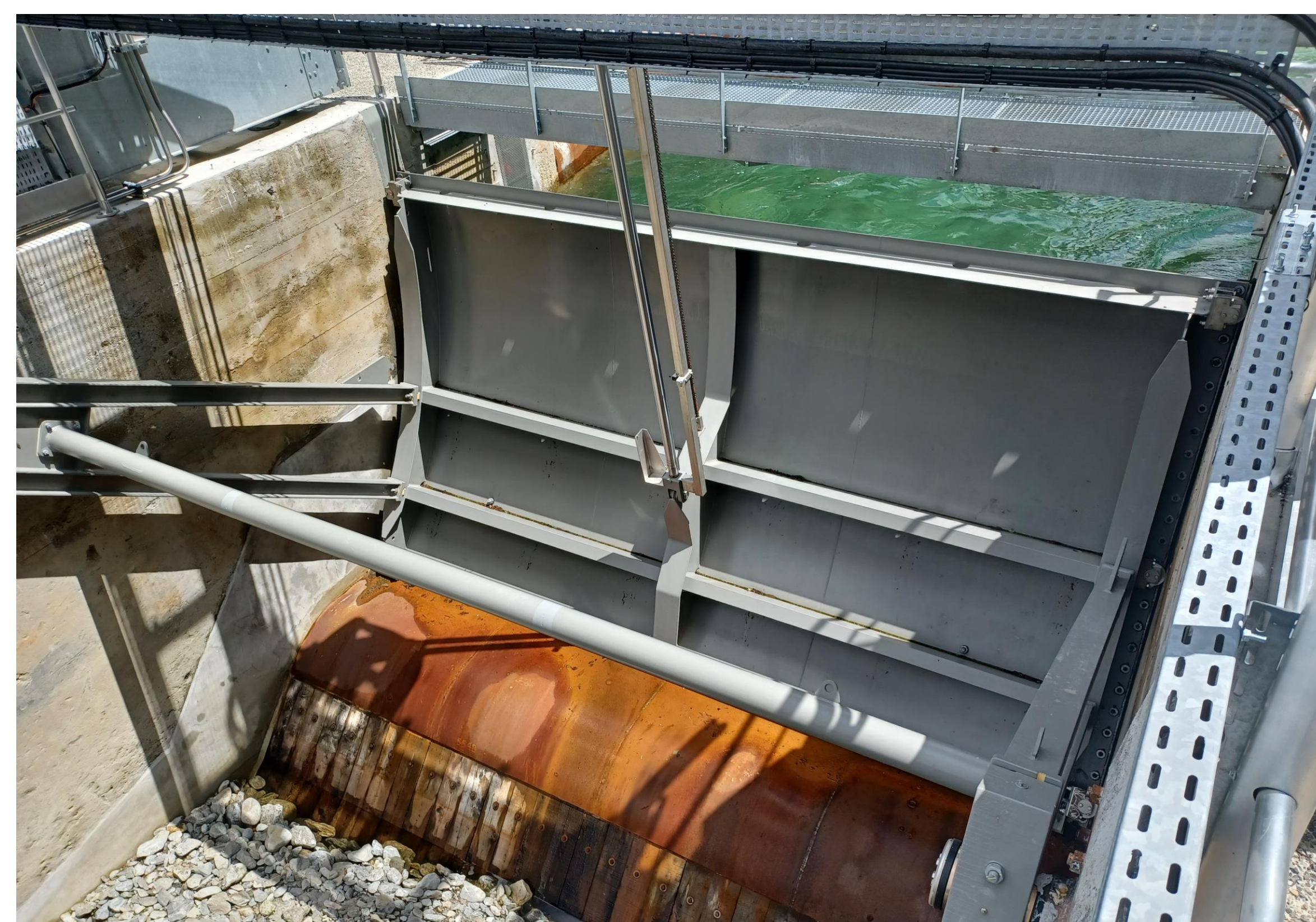
Nouvelle vanne en eau-vue depuis l'aval
