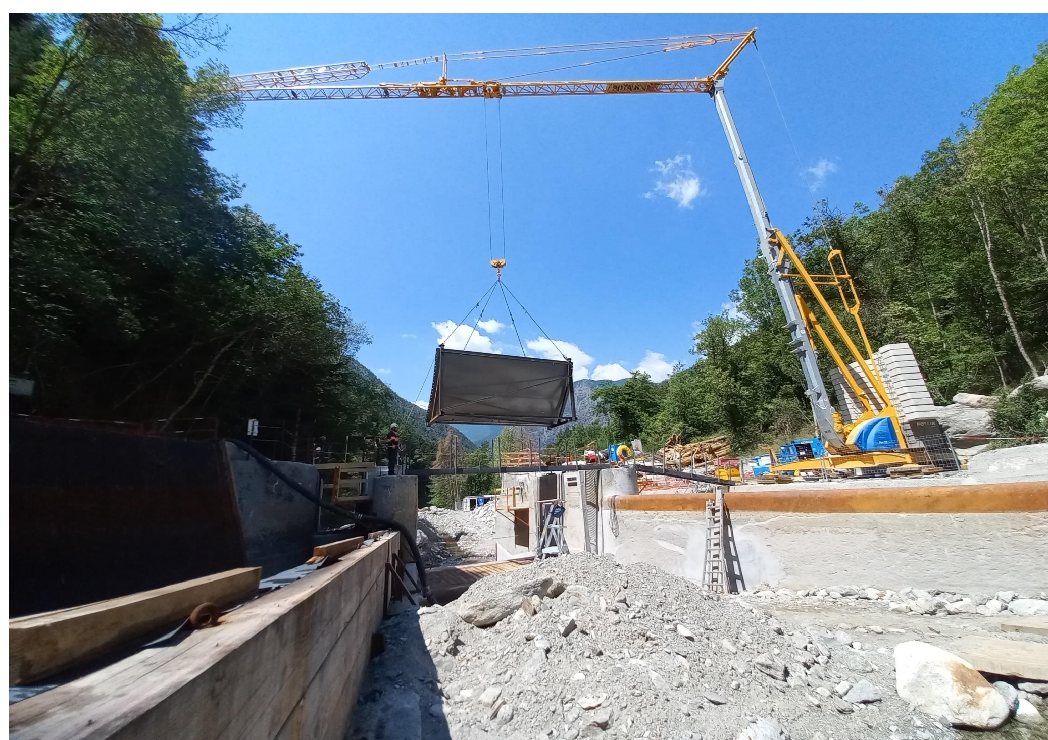
Manutention du bordé par grue
