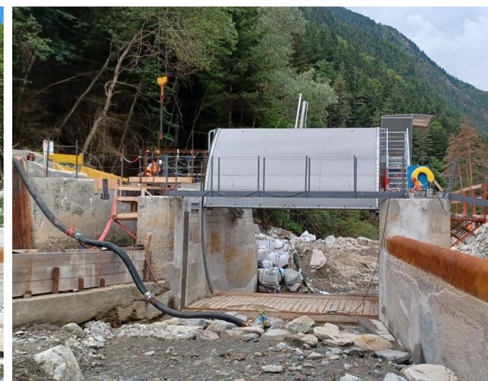
Nouvelle vanne en essai à sec – vue depuis l'amont
