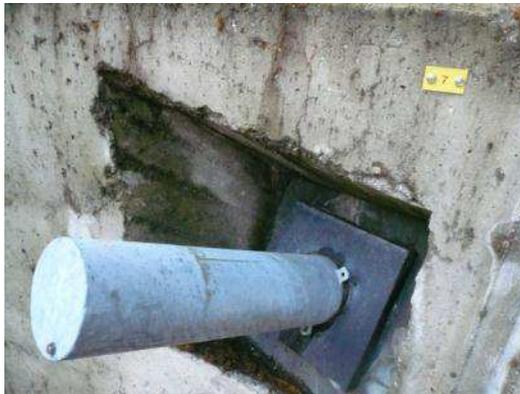
Capot de protection - Joint d'étanchéité
