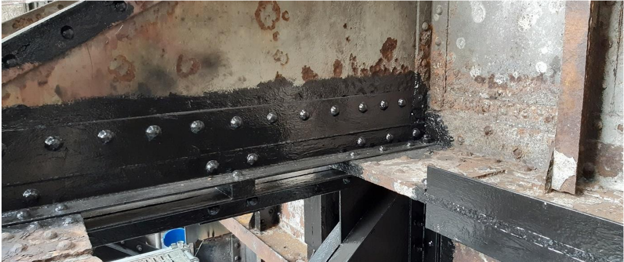
Photo 15 : renforcement d'un montant horizontal de la V1 de Pizançon après peinture
