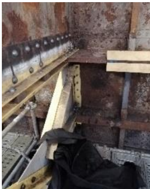
Photo 14 : renforcement du voile 4 de la V1 de Pizançon avant peinture
