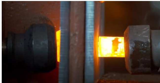
Photo 2 : Mise en place dans le perçage. Gauche contre Buterolle ; Droite Buterolle /!\ : Ne pas se fier à la couleur de la photo qui n'est pas représentative de la réalité.
