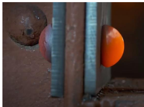
Photo 4 : Le rivet formé va refroidir et se contracter formant ainsi l'assemblage.
